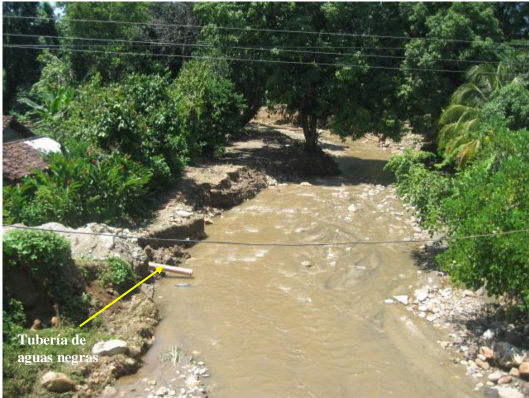
Fotografía No. 2.21.- Punto localizado en Barrio Río Grande, Calle Jardines, AC-055. Observe las descargas directas de agua negras sobre la corriente y sobre el cauce los efectos de la inundación.
