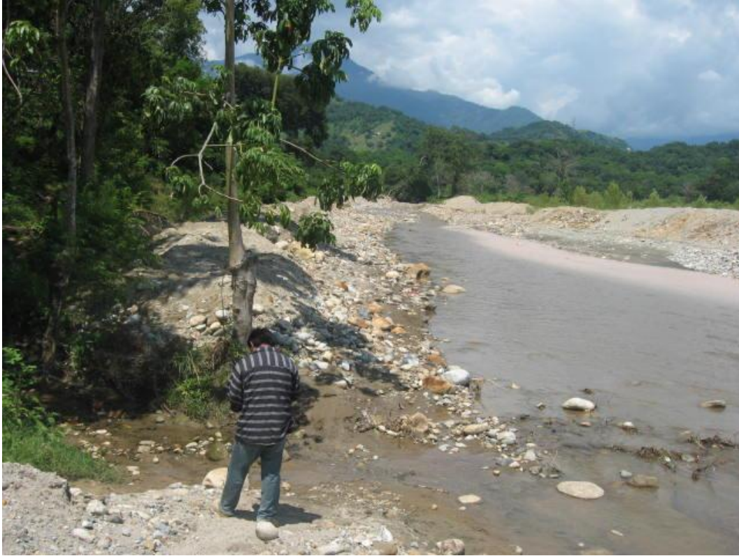
Fotografía No. 2.23).- Limite de los Barrios José Luciano y San Andrés, Calle Matamoros esquina con Benito Juárez, punto AC-061. Observe la construcción de bordos que no sobrepasan los 1.50 m y destrucción actual de los mismos.
