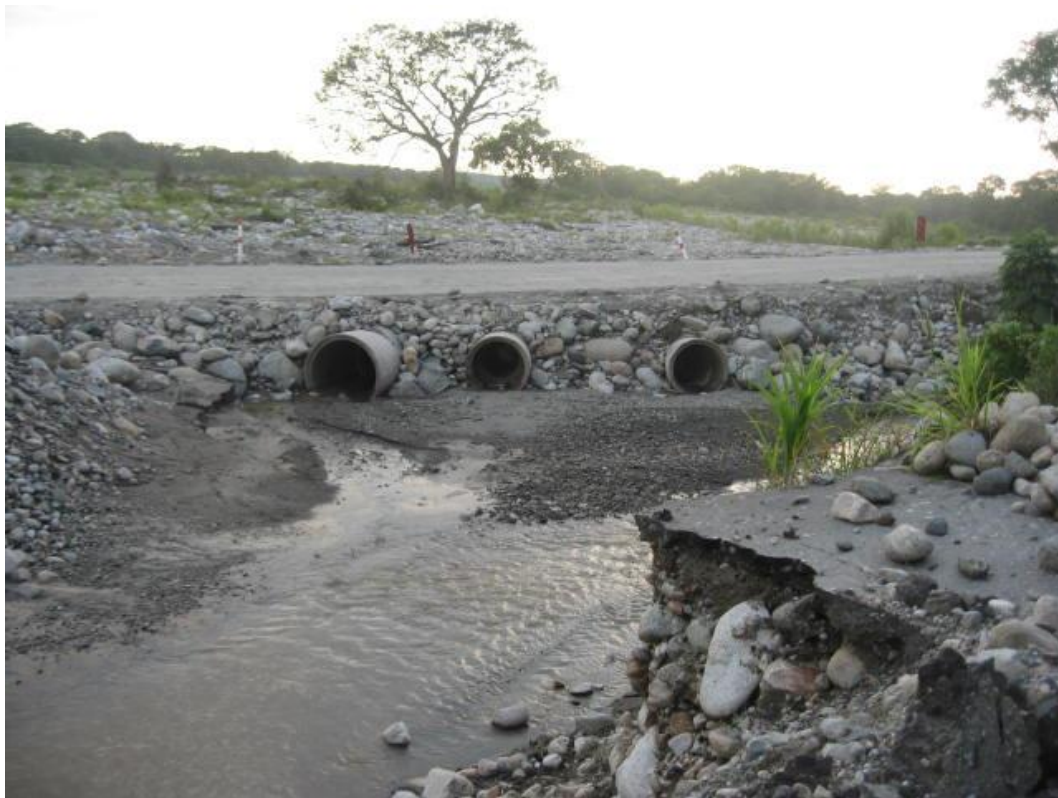
Fotografía No. 2.27).- Punto localizado a 400 m al SE de Playa Inés Sección Dos AC-070, en este punto el río Cintalapa mide 1,700 m de ancho, lugar donde destruyó en ambos sentidos la autopista Arriaga-Tapachula.
