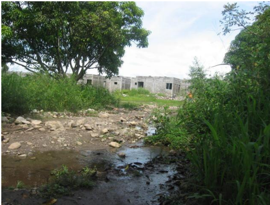
Fotografía No. 2.32).- Punto AC-082, Camino a Jalapa, Fraccionamiento Nuevo Milenio, cuando se edificó este fraccionamiento no se pensó dar paso libre al arroyo Jalapita, motivo por el cual después de las lluvias se sale de cause inundando todo lo que a su paso conlleva hasta buscar la salida de esta corriente.
