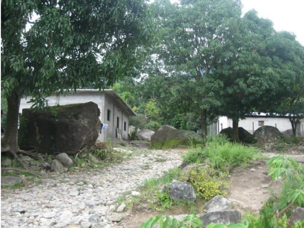
Fotografía No. 2.13.- Punto de control AC-007, localizado en el Ejido Nueva Reforma, observe el tamaño de los bloques con respecto a las viviendas.
