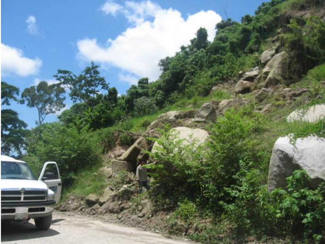
Fotografía No.2.14.- Punto de control AC-032, localizado a 300m al norte de Magnolias, observe el tamaño de los bloques con respecto al vehículo que sirve de escala y la caída de rocas frente a la camioneta.
