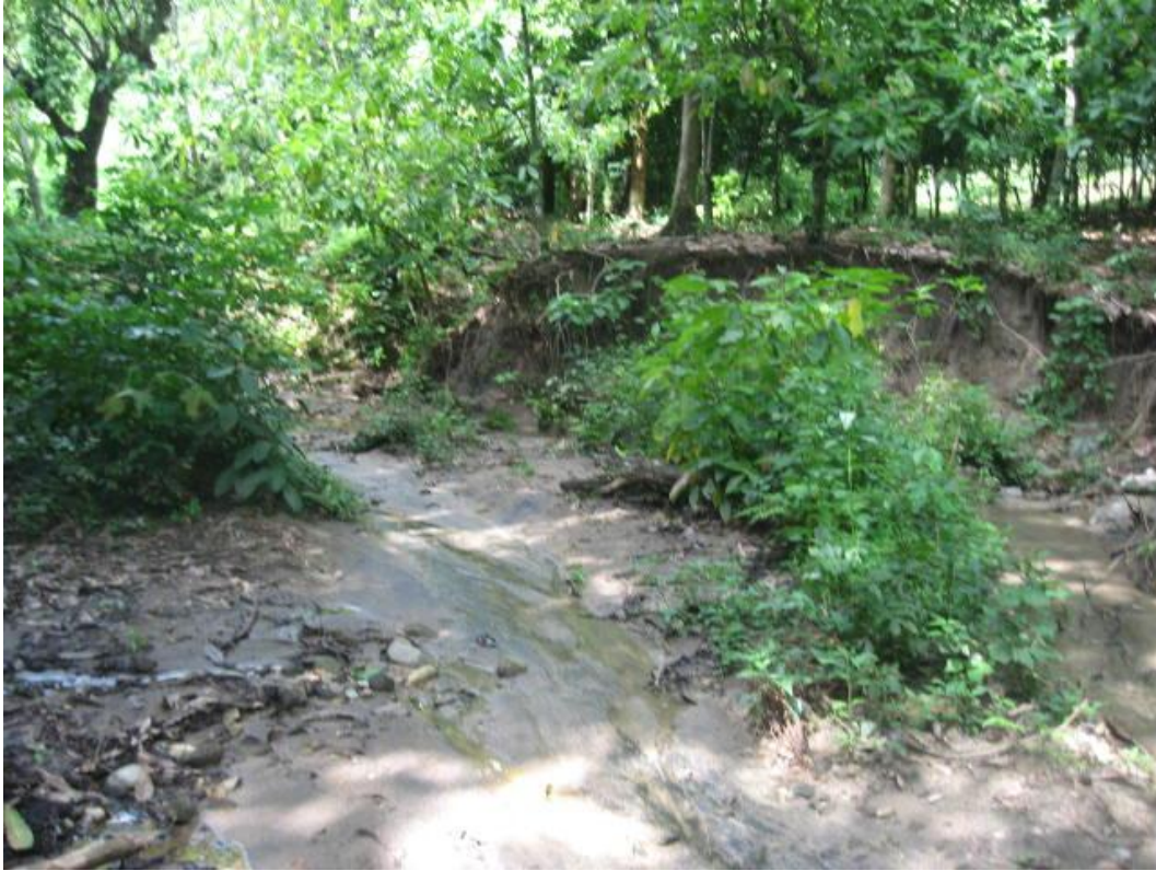
Fotografía No. 2.19.- Punto localizado en el Barrio Morelos I, Calle 16 de Septiembre AC-017. Observe el corte del cauce ocasionado por las inundaciones de octubre del 2005.
