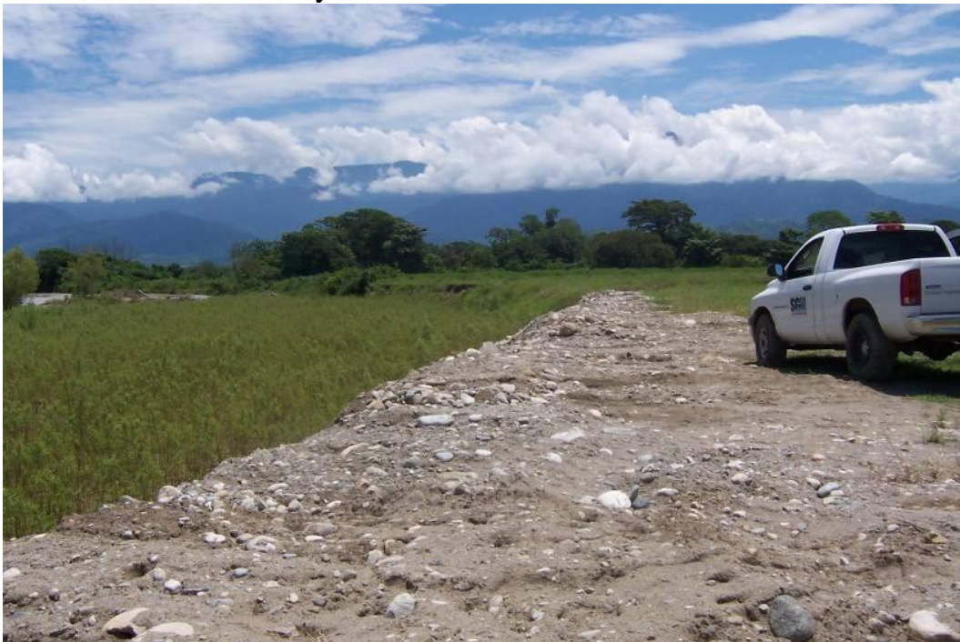
Fotografía No. 2.7.- Punto de verificación AP-001. En esta panorámica se observa los bordos de contención-prevención que se están haciendo, como se aprecia son de arena y grava sin estructura de acero o concreto, por lo tanto son muy débiles.
