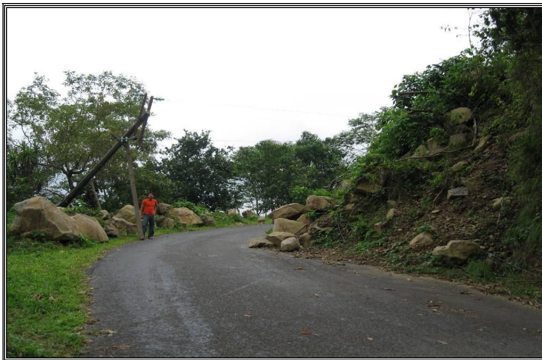
Fotografía No 2.6.- Caída de Bloques en el Municipio de Cacahoatán.
