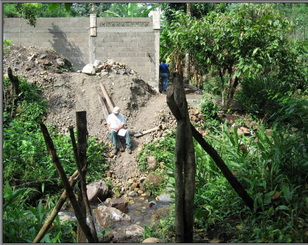
Fotografía No. 2.9.- Ubicación de viviendas sobre la margen izquierda del Río Izapa (barrio Belisario Domínguez).
