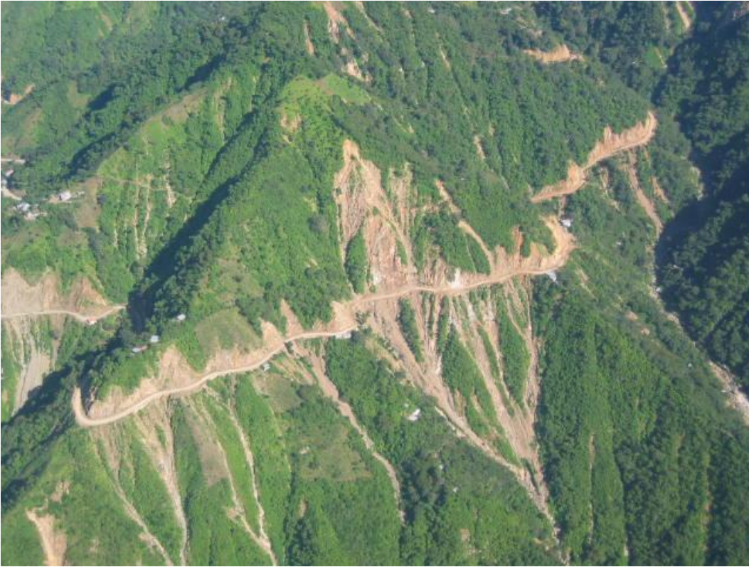
Fotografía No 2.3.- Erosión concentrada asociada a cauces y cañadas (Ec1), en el centro de la fotografía y con pendientes muy fuertes se observa deforestación natural asociada a inestabilidad de laderas y a erosión antrópica por obras civiles (Ea3).
