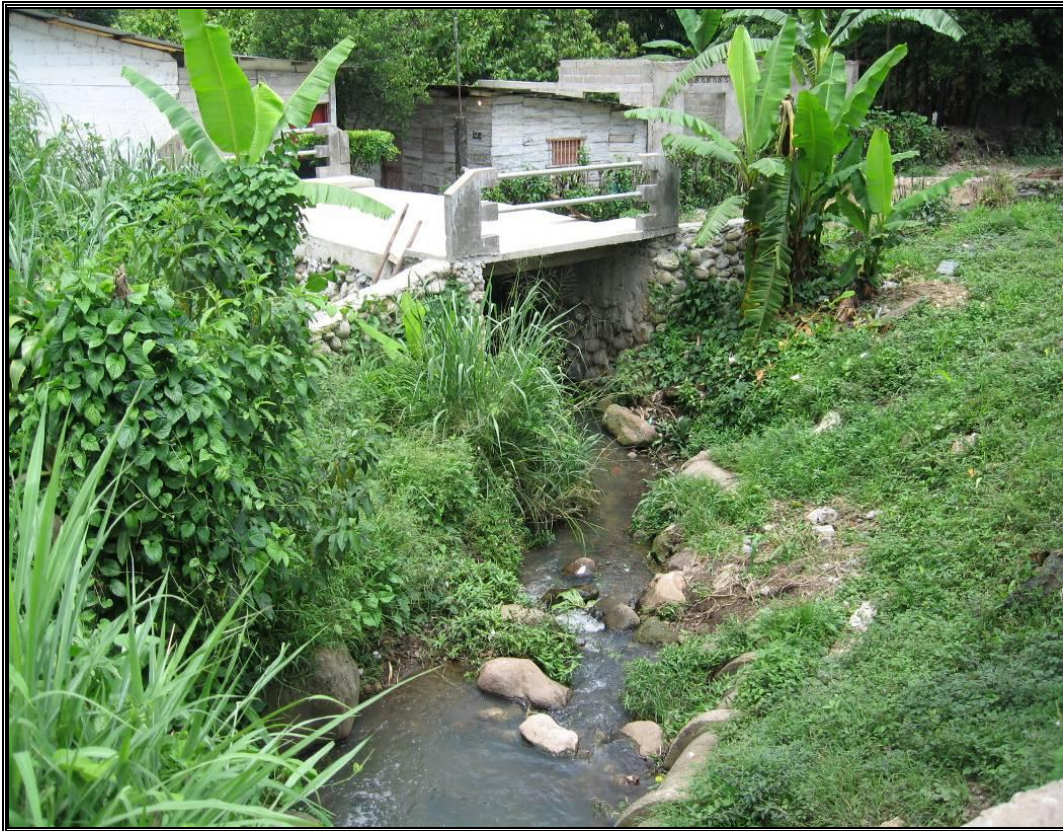
Fotografía No. 2.14.- Sobre el cauce del arroyo Panzero I.
