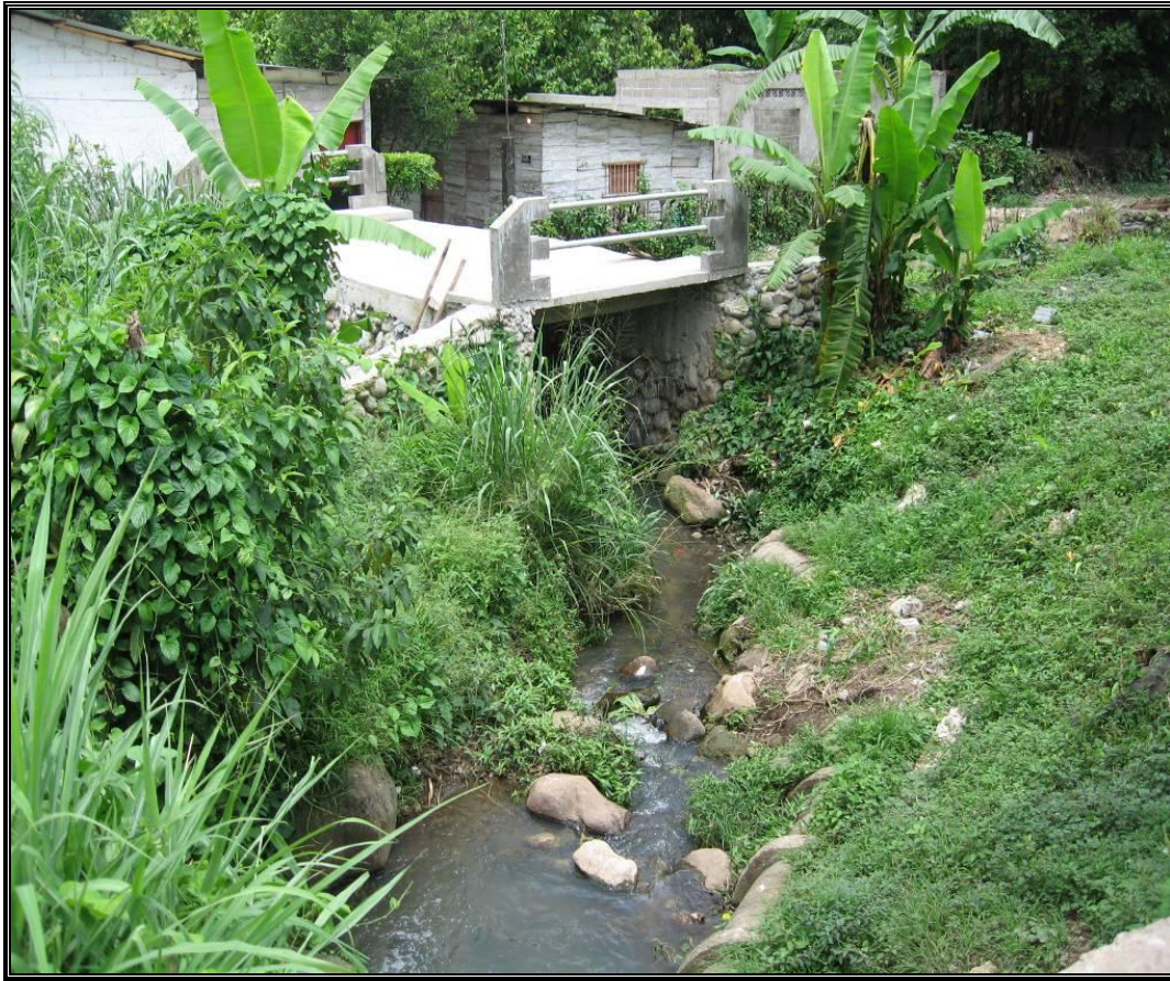
Fotografía No. 2.10.- Ubicación de viviendas que descargan sus aguas residuales sobre los cauces de arroyos del barrio Belisario Domínguez.
