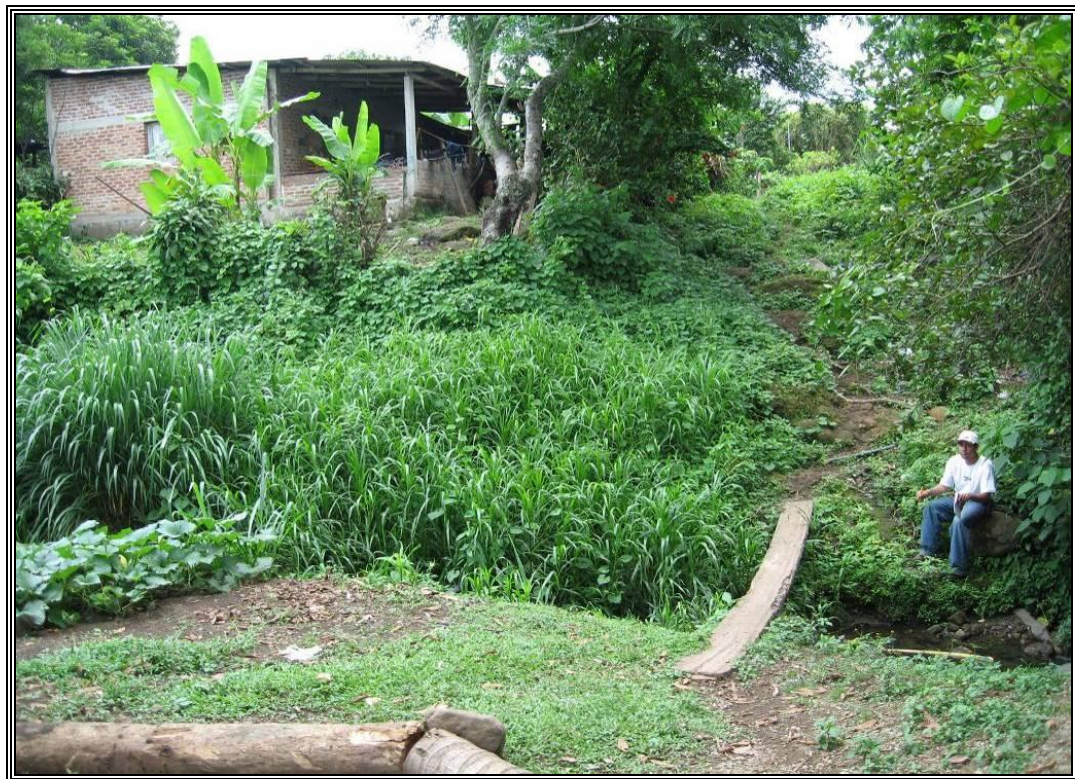
Fotografías No. 2.8.- Afectación por peligro de inestabilidad de laderas en la ciudad de Cacahoatán.
