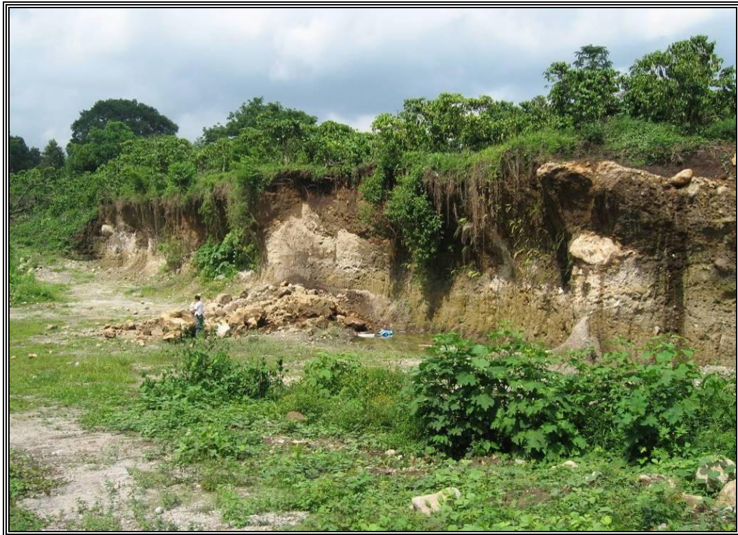
Fotografías No. 2.7.- Afectación por caída de bloques en la ciudad de Cacahoatán.
