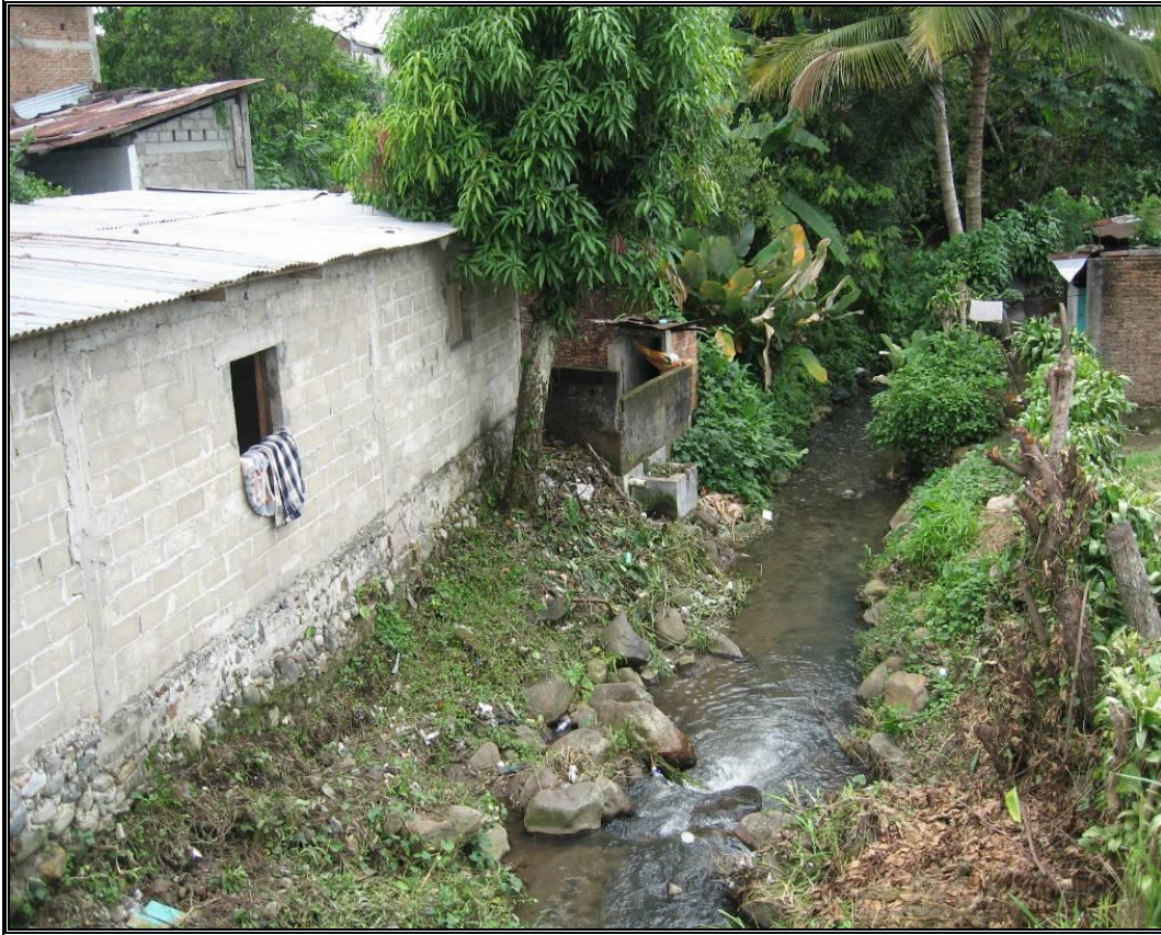
Fotografía No. 2.16.- Sobre el cauce del arroyo Panzero II.
