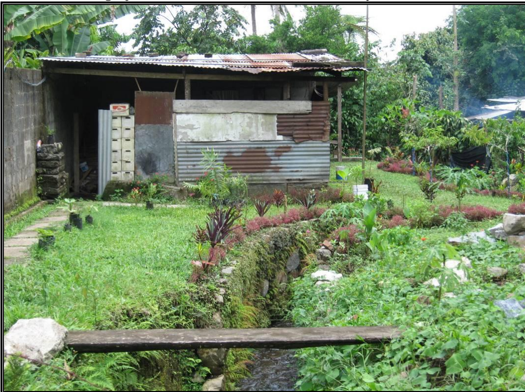
Fotografía No. 2.15.- Sobre el cauce del arroyo Huehuecho.
