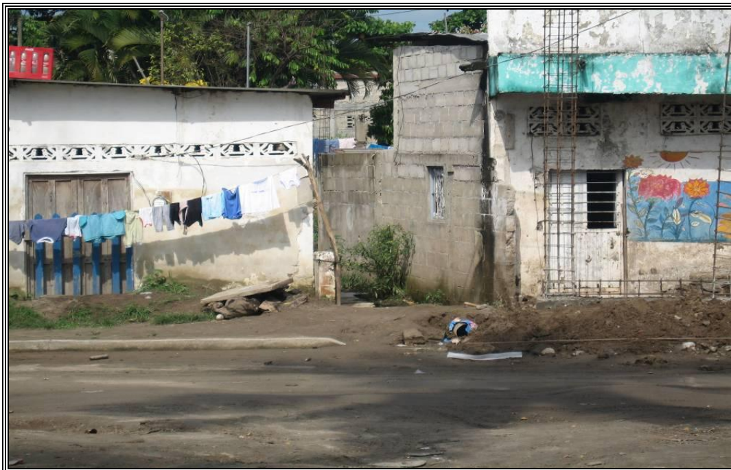
Fotografía No 2.9.- Punto ubicado sobre el callejón 3ero de la Colonia El Carmen donde se midió un espesor de inundación de 1.67 m y 0.40 m de espesor de sedimento; esta vivienda aun se encuentra habitada.
