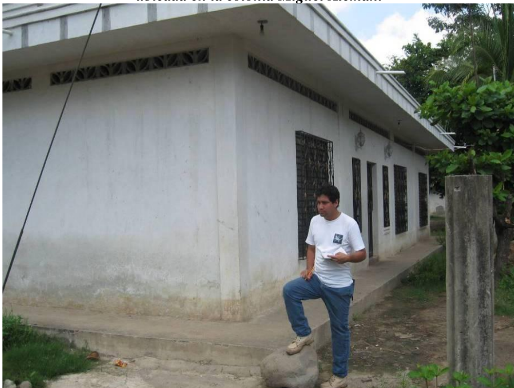
Fotografía No. 2.21.- Afectaciones a las viviendas que se ubican en la colonia La Libertad (en su porción Sur) donde el nivel del agua subió 0.57 m.
