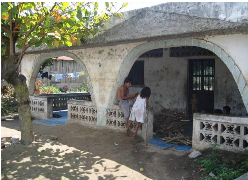
Fotografía No. 2.23.- Afectaciones a las viviendas que se ubican en la colonia La Libertad (sobre la carretera La Libertad-Ciudad Hidalgo) donde el nivel del agua subió 1.30 m.
