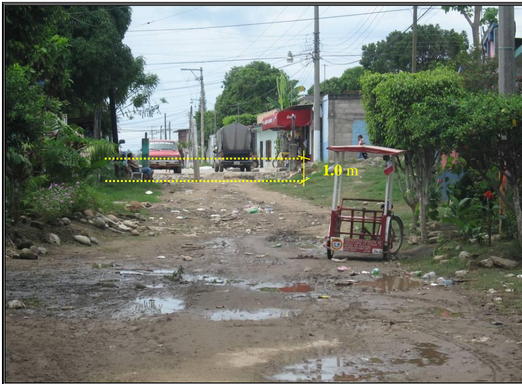
Fotografía No. 2.11.- Condiciones actuales en que se encuentra el bordo que no permitía la inundación de la colonia 26 de Julio.
