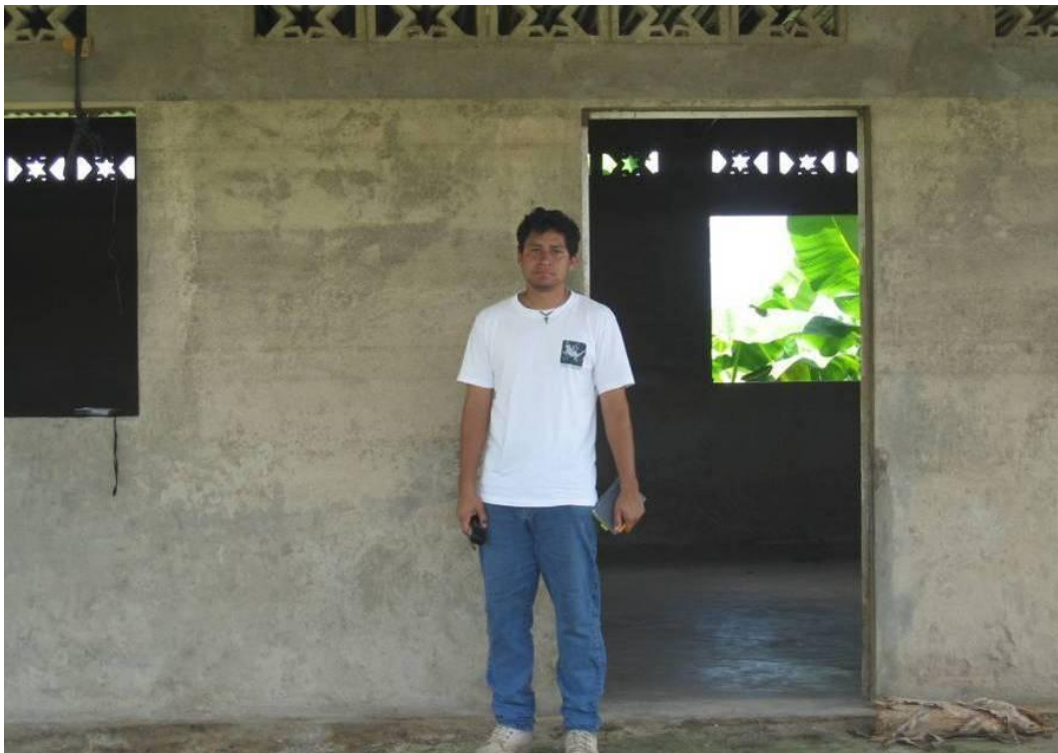
Fotografía No. 2.24.- Afectaciones a las viviendas que se ubican en la colonia Ignacio López Rayón en su porción oriente (ubicado a aprox. 250 m) donde el nivel del agua subió 2.09 m.
