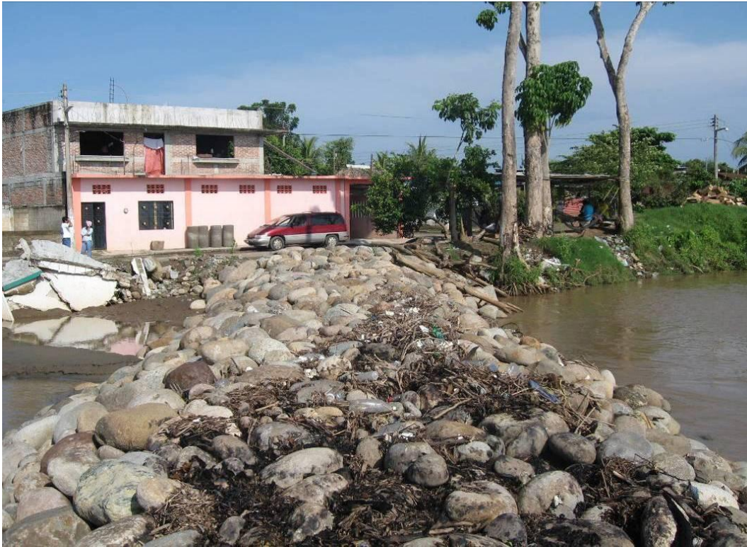
Fotografía No. 2.14.- Detalle de espigones ubicados en la cabecera municipal de Ciudad Hidalgo.
