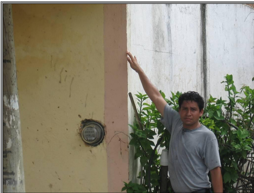
Fotografía No. 2.10.- Punto ubicado sobre la Calle #7 Colonia 26 de Julio donde se midió un nivel de inundación de 2.13m m y 0.74 m de espesor de sedimento.
