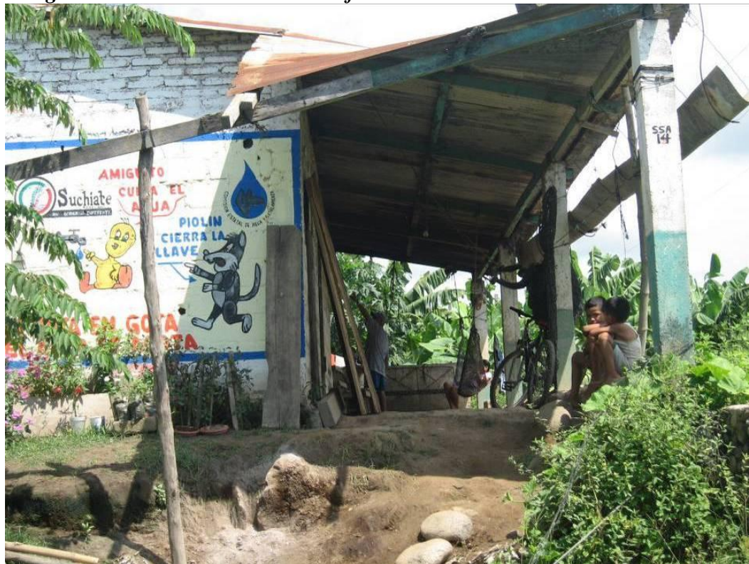
Fotografía No.2.19.- Vivienda ubicada entre el cauce del Río Suchiate y el Canal de Riego que abastece los platanales del distrito de riego de la colonia Miguel Alemán en donde el nivel del agua fue de 1.07 m.
