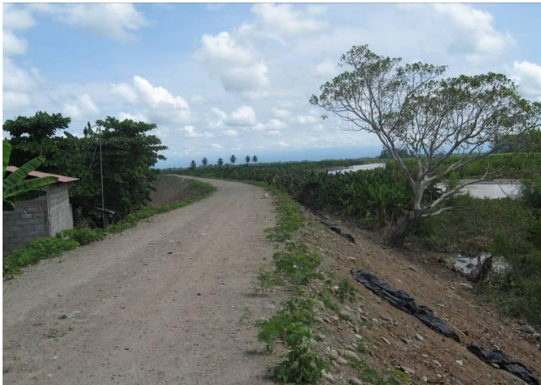
Fotografía No. 2.18.- Bordo ubicado frente al cauce del Río Suchiate en la colonia Miguel Alemán el cual tiene como función evitar la inundación de la misma.
