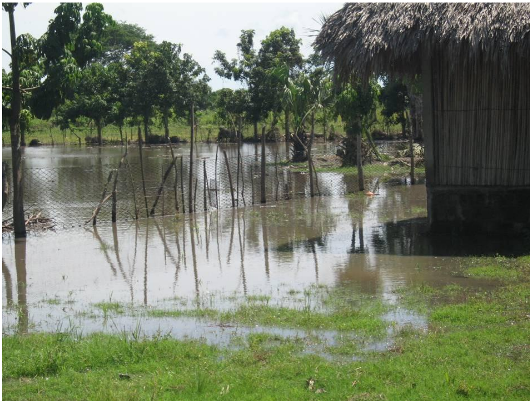
Fotografía No. 2.30.- Afectaciones a las viviendas que se ubican en la colonia Emiliano Zapata donde el nivel del agua subió 1.05 m.
