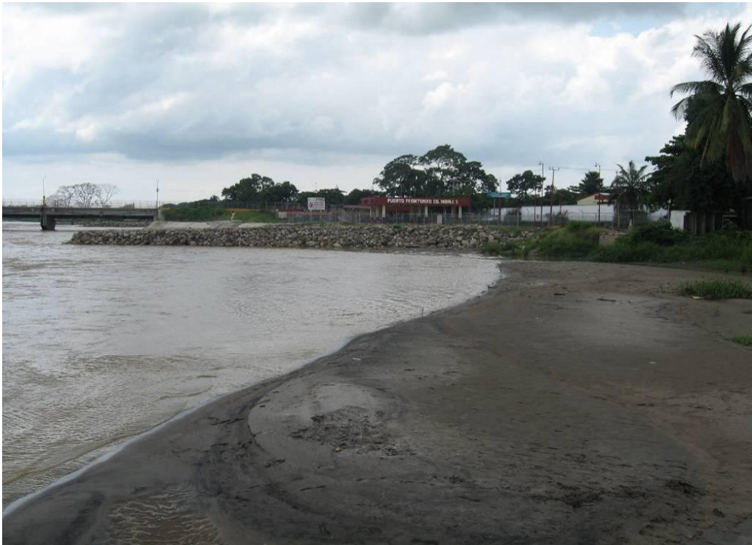
Fotografía No. 2.15.- Espigón construido aledañosamente a la cabecera municipal (Ciudad Hidalgo) el cual fue construido con la intención de evitar la destrucción del puente fronterizo (México-Guatemala).
