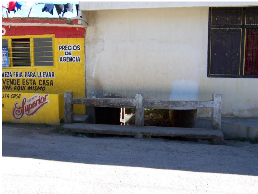
Fotografía 10. Obsérvese la construcción de algunas casas sobre el cauce de un arroyo, utilizándolo como desembocadura del drenaje de la zona urbana (1ª Calle Norte Poniente).
