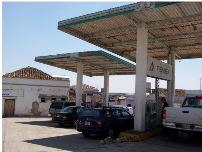
Fotografía 22, Antigua Gasolinera Ulises
