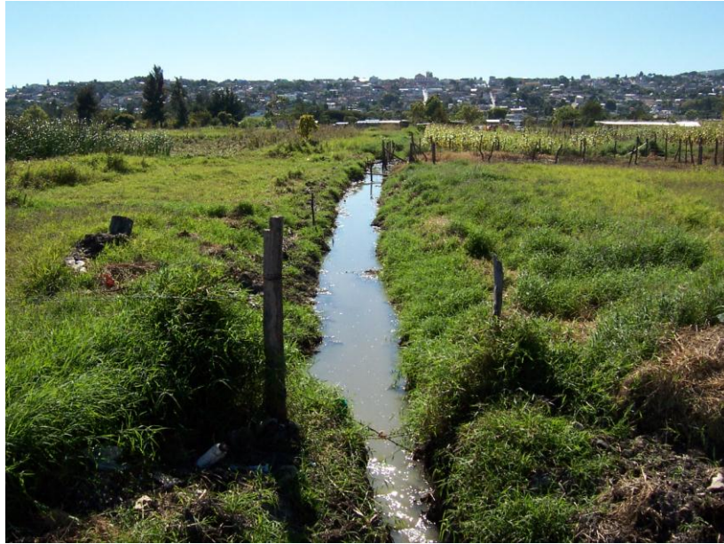
Fotografía 24 . Desembocadura del agua residual de la ciudad de Comitán, que en época de lluvia afecta las zona urbana y áreas de agricultura de temporal (Barrio Jerusalén).
