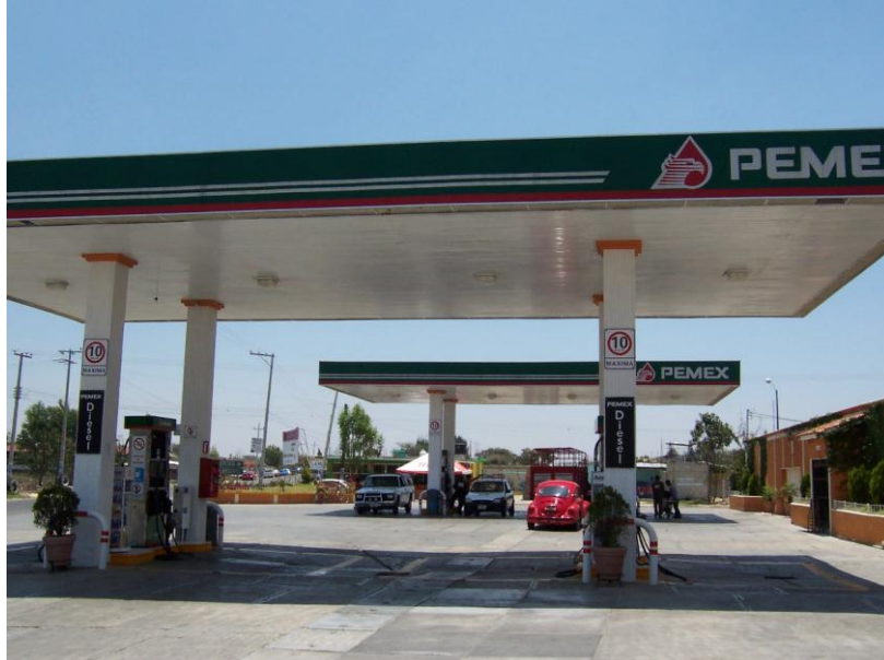
Fotografía 15, Estación de servicio en el barrio El Cedro. Nótese el estado apropiado de la estación.
