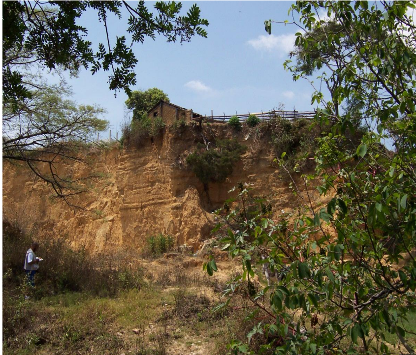
Fotografía 4.- Deslizamiento de materiales poco consolidados debido a la extracción de material para la elaboración de ladrillos.
