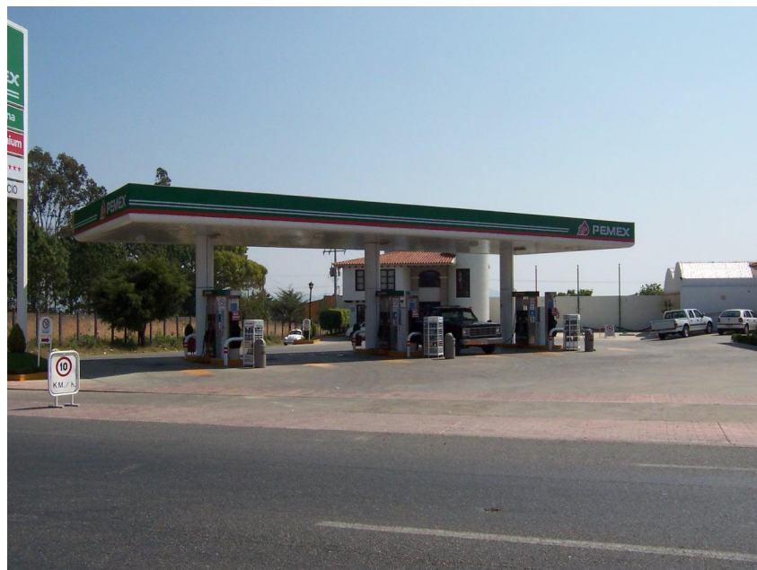
Fotografía 14, Estación de servicios, Grupo AMAREL
