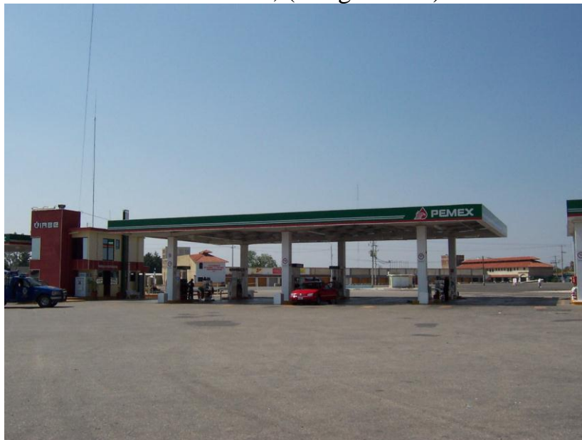
Fotografía 18, Gasolinera Villatoro. Obsérvese el buen estado físico.
