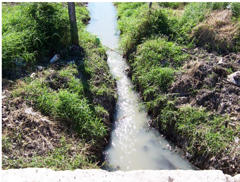
Fotografía 25 . Desembocadura del agua residual de la ciudad de Comitán, obsérvese que el canal de desembocadura es muy pequeño y no presenta algún tipo de protección `por lo que las aguas negras se infiltran al terreno. (Barrio Jerusalén).
