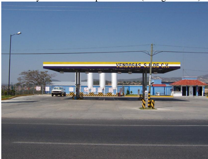
Fotografía 16, Planta de carburación Vendogas, S.A. de C.V. Obsérvese el buen estado físico.
