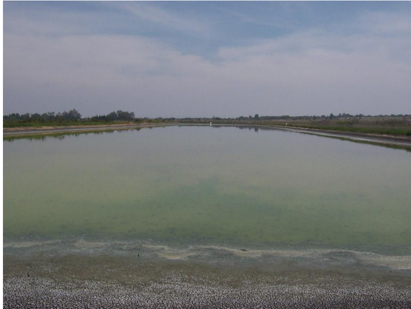
Fotografía 27, Estanque de Oxidación I
