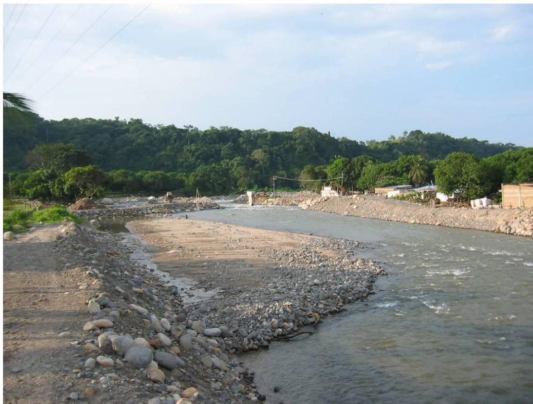
Fotografía 2.42.- Bordos de contención sobre las márgenes del Río Huehuetán en las inmediaciones de la cabecera municipal
