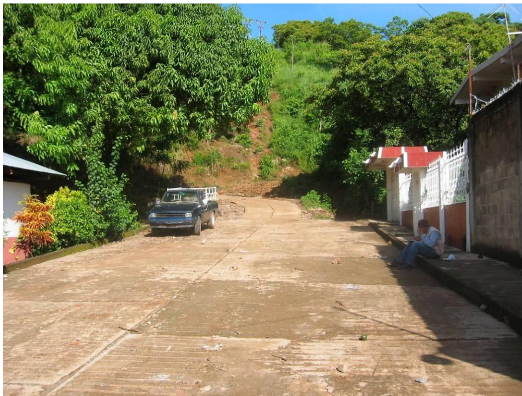
Fotografía 2.21.- Viviendas expuestas a peligro alto por deslizamiento ubicadas al final de la calle 2ª Poniente. Nótese la ubicación de las viviendas.
