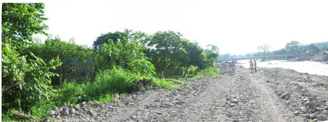
Fotografía 2.81.-Barrio Tres Marías, ubicado sobre la margen izquierda del río Huehuetán. Obsérvese la ubicación de las viviendas.
