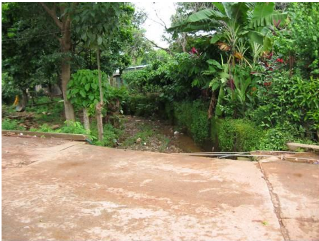
Fotografía 2.61.-Calle 2ª Norte, las viviendas expuestas a peligro alto por inundación. Obsérvese la cercanía de las viviendas con el arroyo.
