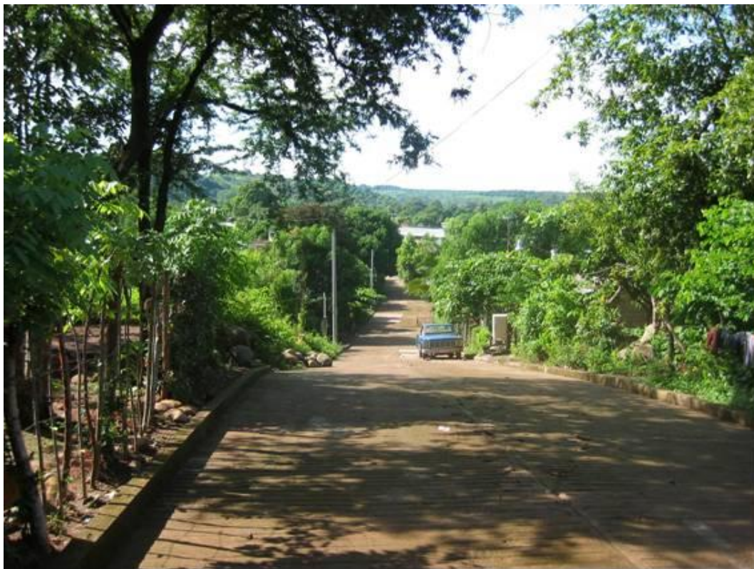
Fotografía 2.22.- Viviendas ubicadas al final de la calle 2ª Poniente expuestas a peligro por deslizamiento de ladera. Nótese la ubicación de las viviendas.
