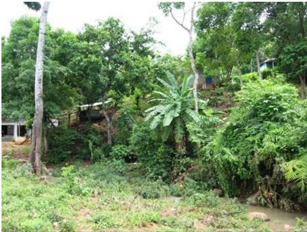
Fotografía 2.16.- Viviendas en peligro alto por deslizamiento en el poblado Guadalupe. Obsérvese la altura a la que se encuentran ubicadas.
