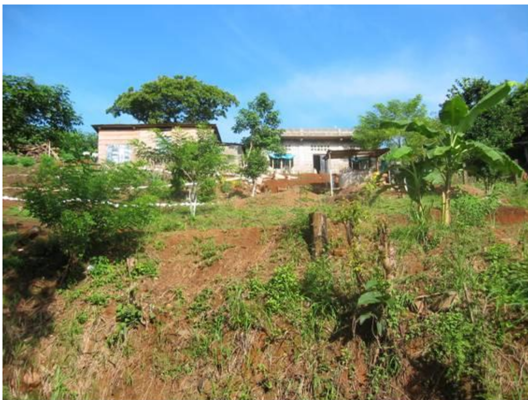
Fotografía 2.20.- Viviendas expuestas a peligro alto por deslizamiento ubicadas en la Col. San Agustín. Nótase la ubicación de las viviendas.
