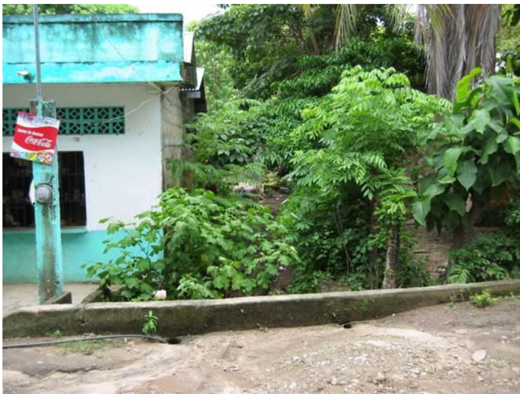
Fotografía 2.64.- Arroyo ubicado sobre la calle 5ª Oriente. Nótese la ubicación de la vivienda
