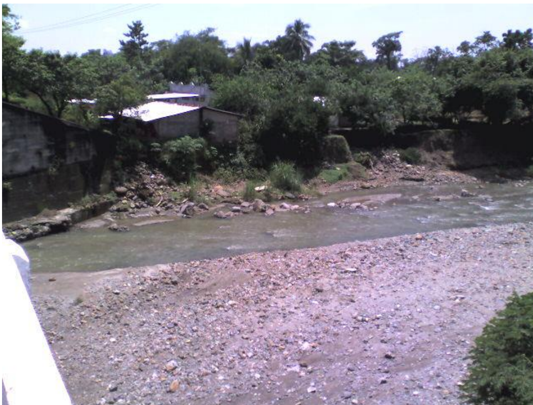
Fotografía 2.28.- Río Chamulapa en las cercanías al poblado Chamulapa. Nótese el grado de peligro de las viviendas ubicadas en el margen izquierdo.
