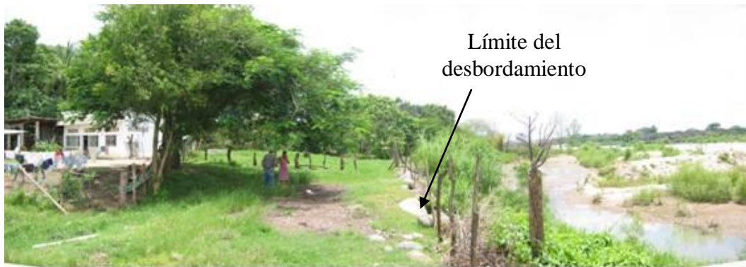
Fotografía 2.91.-Viviendas pertenecientes al Barrio Guadalupe ubicadas sobre la margen derecha del Río Huehuetán. Obsérvese la ubicación de las mismas.
