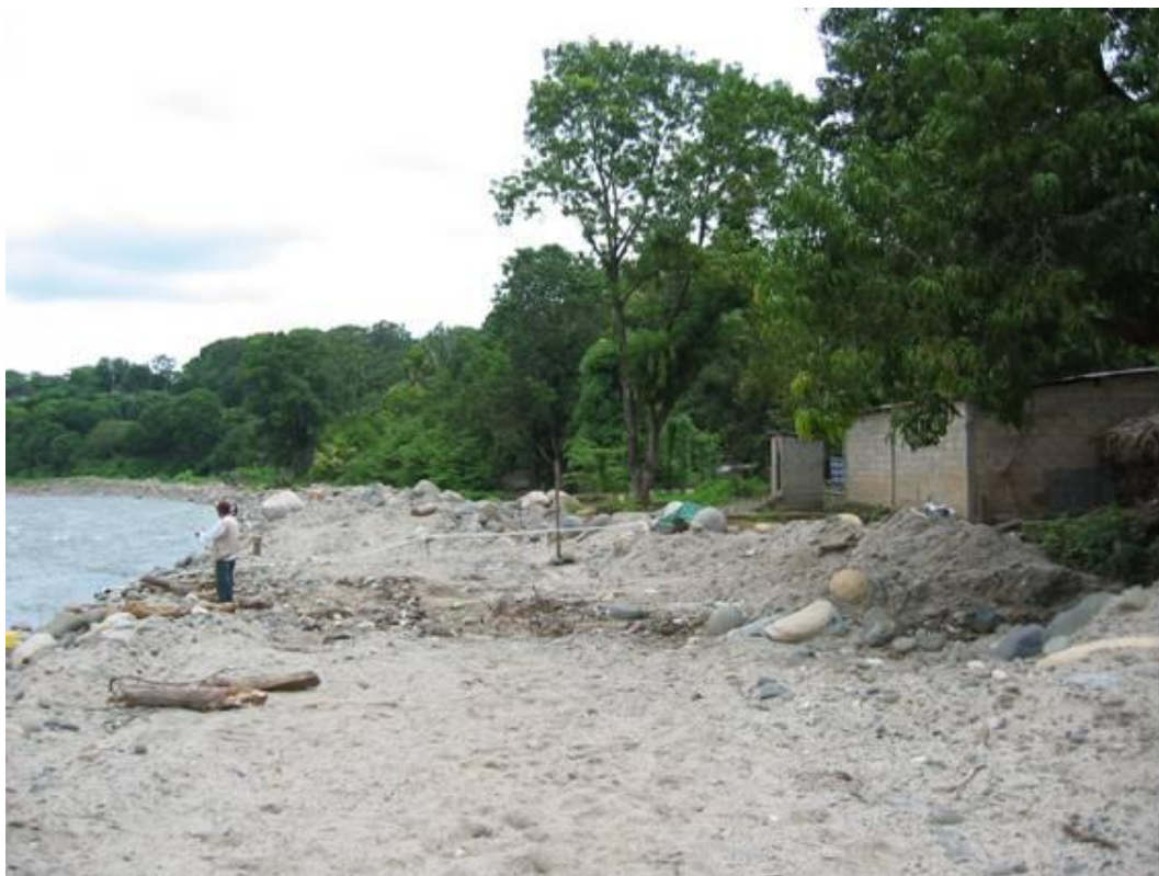
Fotografía 2.76.- Viviendas ubicada sobre la margen derecha del río. Obsérvese la distancia con el cauce.
