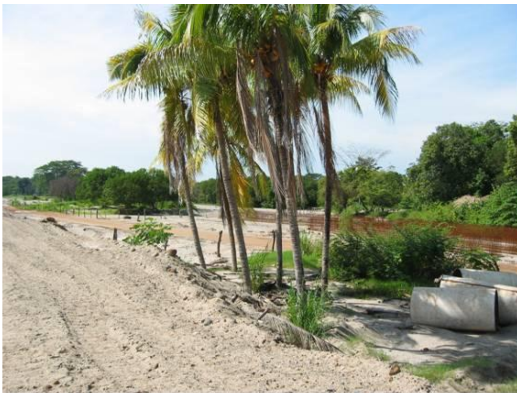
Fotografía 2.85.- Terrenos pertenecientes al Cantón Texpuyo sobre margen izquierda del río, aquí existían 30 viviendas que fueron arrasadas por la creciente.
