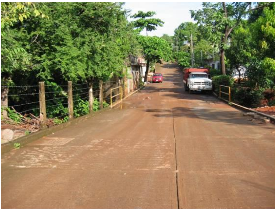
Fotografía 2.60.- Calle 9ª Poniente, las viviendas están expuestas a peligro alto por inundación. Obsérvese la pendiente de la calle de enfrente, que continuamente presenta escurrimientos afectando a esta zona
