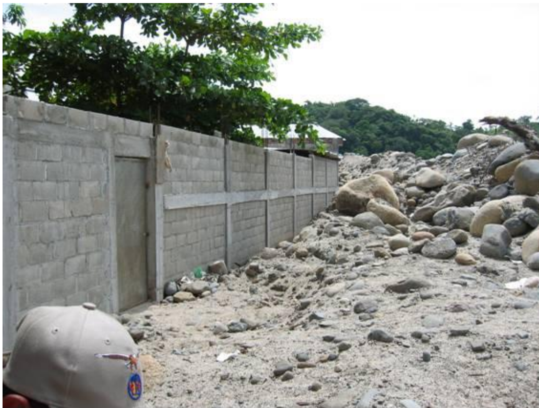
Fotografía 2.75.- Vivienda ubicada sobre la margen derecha del río. Obsérvese el tamaño de los bloques que se utilizan para la construcción de los bordos de contención.
