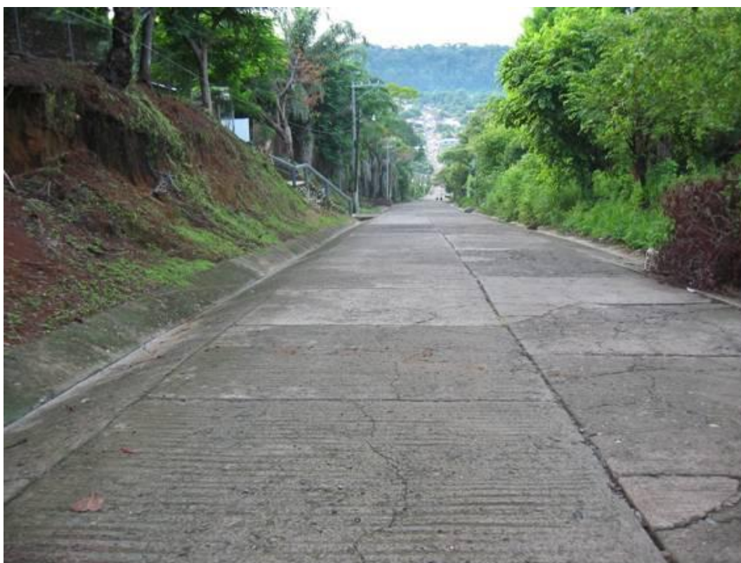
Fotografía 2.24.- Viviendas ubicadas al final de la calle 1ª Av. Poniente expuestas a peligro por deslizamiento de ladera. Nótese la pendiente de la calle.
