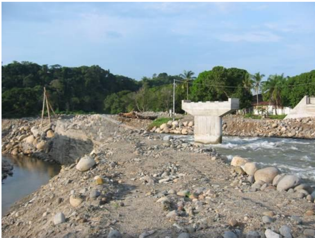
Fotografía 2.70.- Destrucción de puente por el paso de la corriente del río Huehuetán. Nótese el grado de afectación
