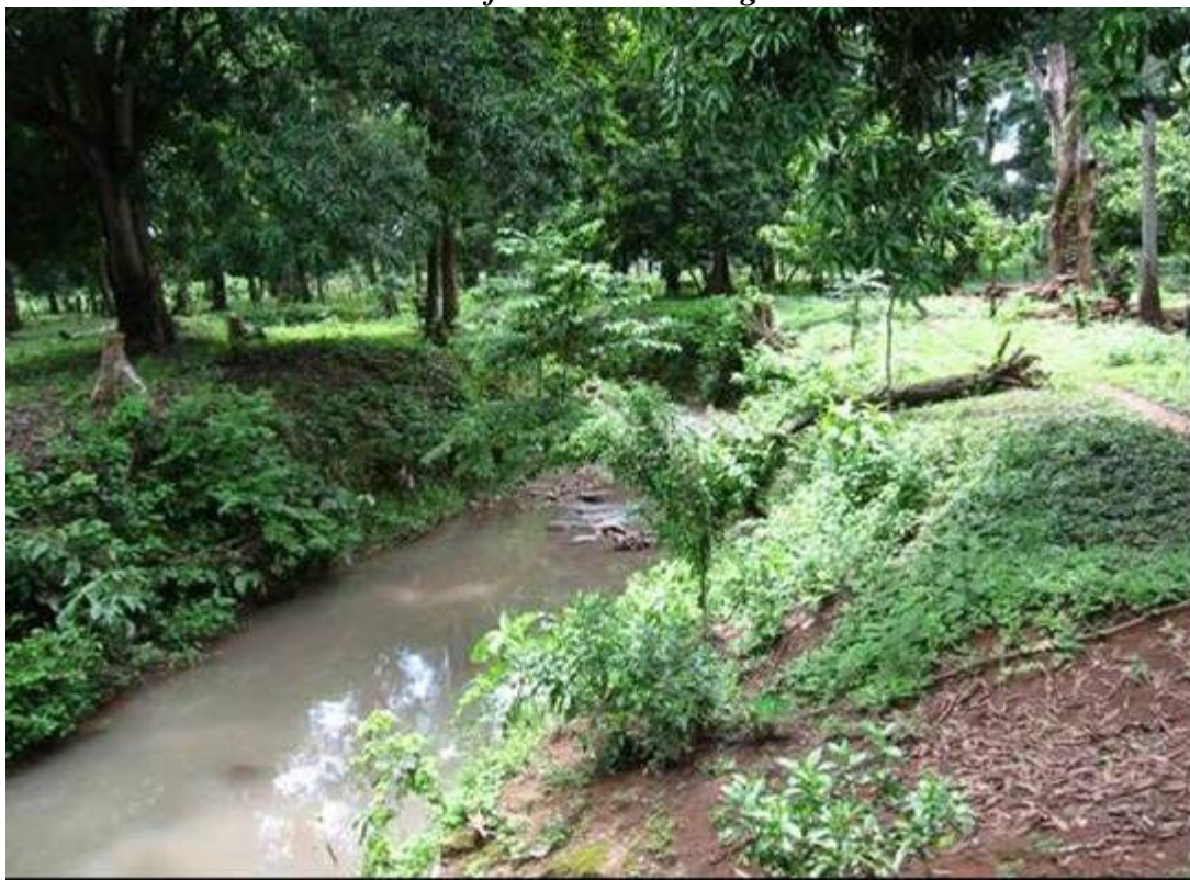
Fotografía 2.33.-Zona de afectación del desbordamiento del Río Cuyamiapa. Obsérvese la topografía plana
