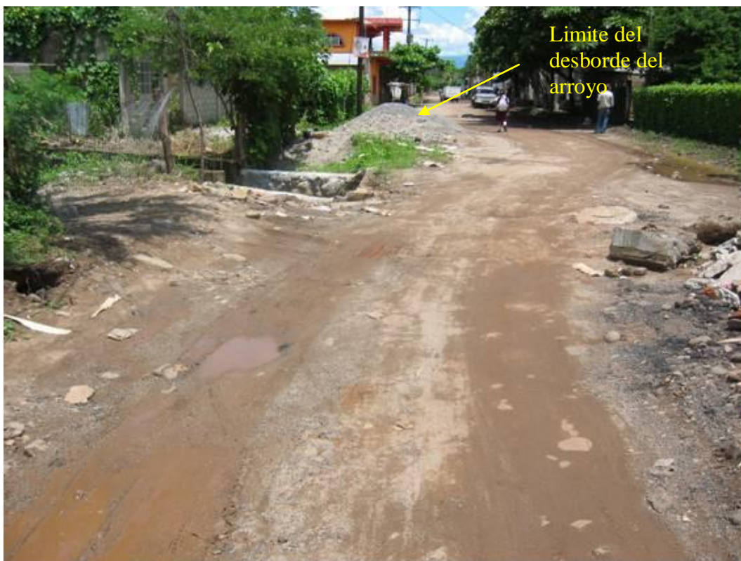
Fotografía 2.92.- Arroyo que cruza la calle Francisco I. Madero. Nótese hasta donde llegó el agua.
