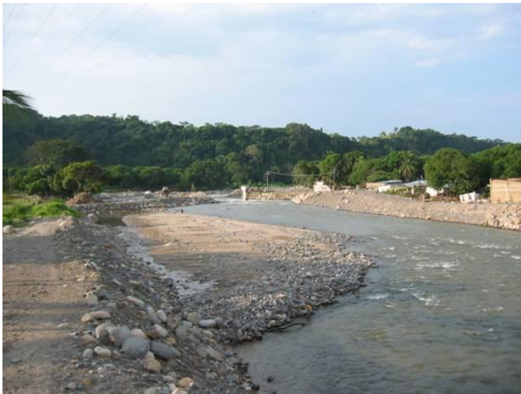
Fotografía 2.44.- Bordos de contención sobre las márgenes del Río Huehuetán en las inmediaciones de la cabecera municipal
