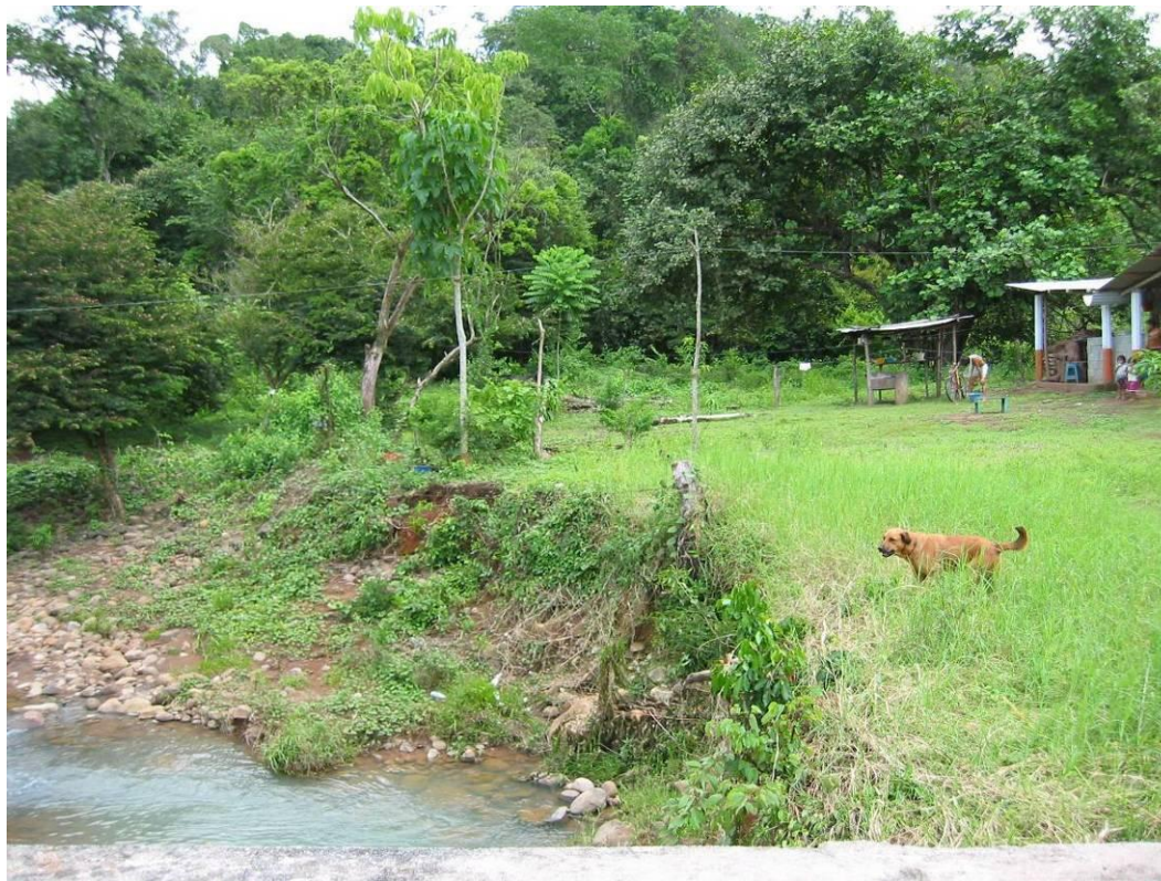
Fotografía 2.57.- Cantón Nexapa. Vivienda expuesta a peligro alto por inundación. Nótese las dimensiones del Arroyo.
