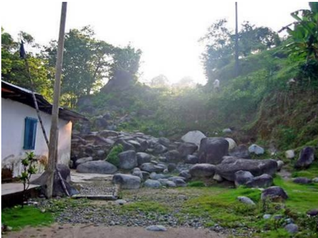
Fotografía 2.8.- Viviendas expuestas a sufrir daños por caída de bloques en el poblado Chamulapita. Obsérvese la ubicación de las mismas.
