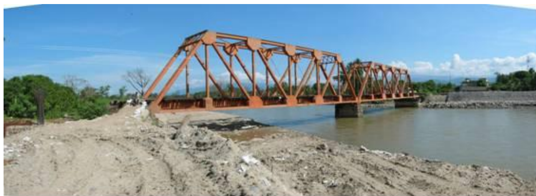
Fotografía 2.84.- Puente dañado por la creciente del río. Nótese la altura de este con respecto al espejo de agua.
