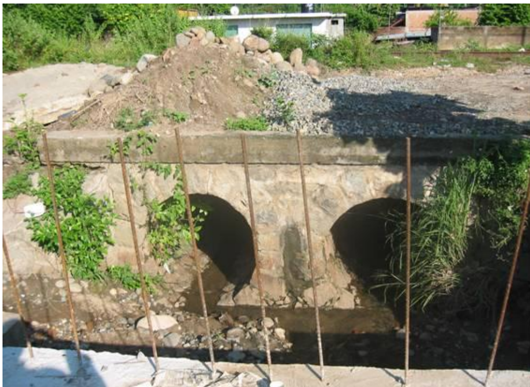
Fotografía 2.94.- Obra civil (Puente) sobre el arroyo en la Av. Panamericana.
