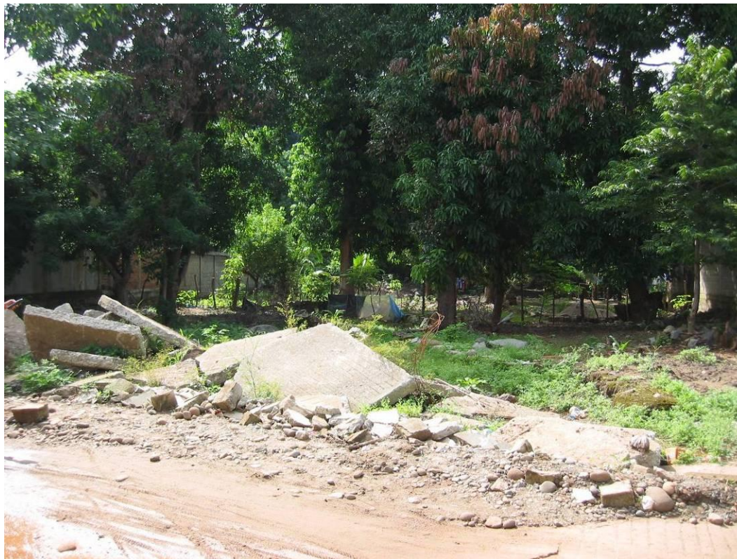
Fotografía 2.73.- Destrucción de bardas sobre la 3ª Av. Norte por el paso de la corriente.
