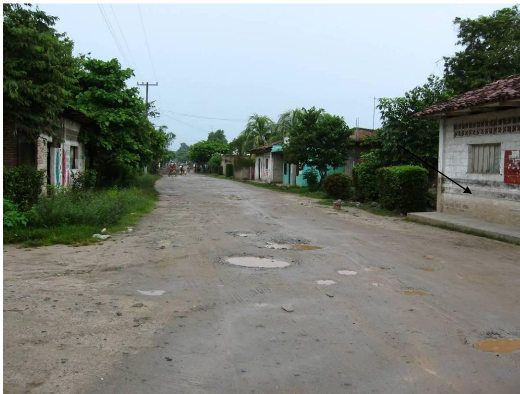
Fotografía 2.51.- Poblado Plan de Ayala. Obsérvese hasta donde llegó el nivel de agua en la vivienda
