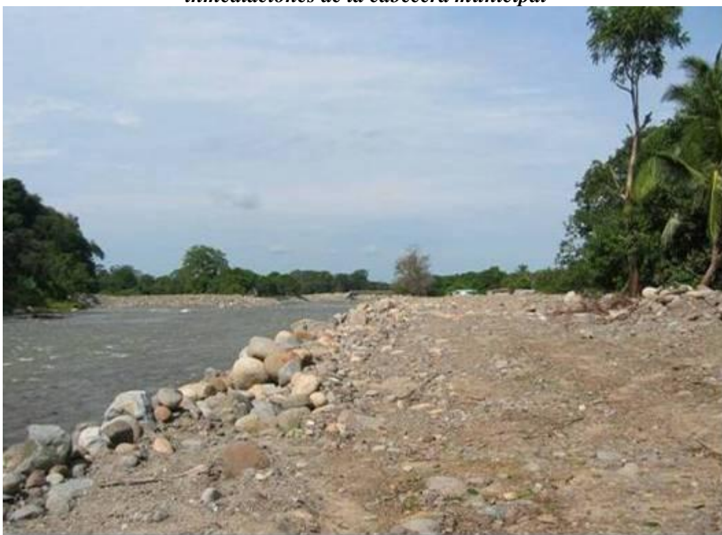
Fotografía 2.43.- Margen izquierda del Río Huehuetán, a la altura del final de la calle 3ª Oriente. Obsérvese los bordos de contención sobre los márgenes.
