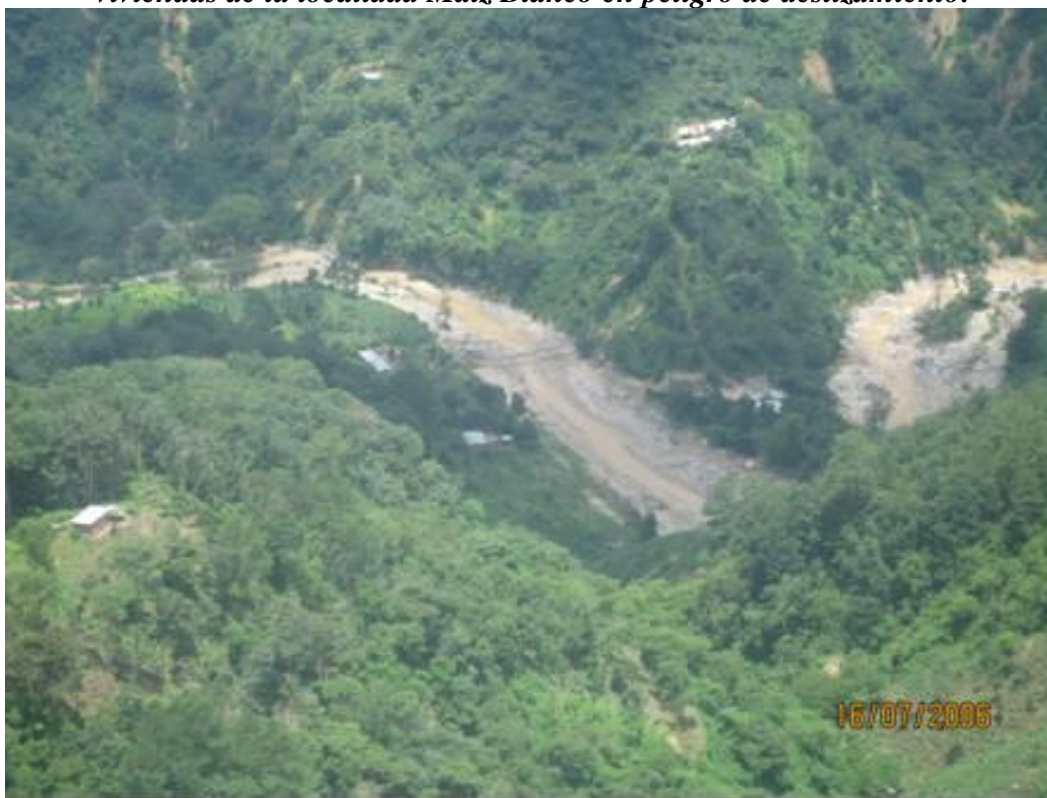
Fotografía 2.24.- Se observa el río Etzumú a la altura de la localidad del mismo nombre. Nótese la ampliación del cauce en ambos extremos y las viviendas cercanas al cauce.
