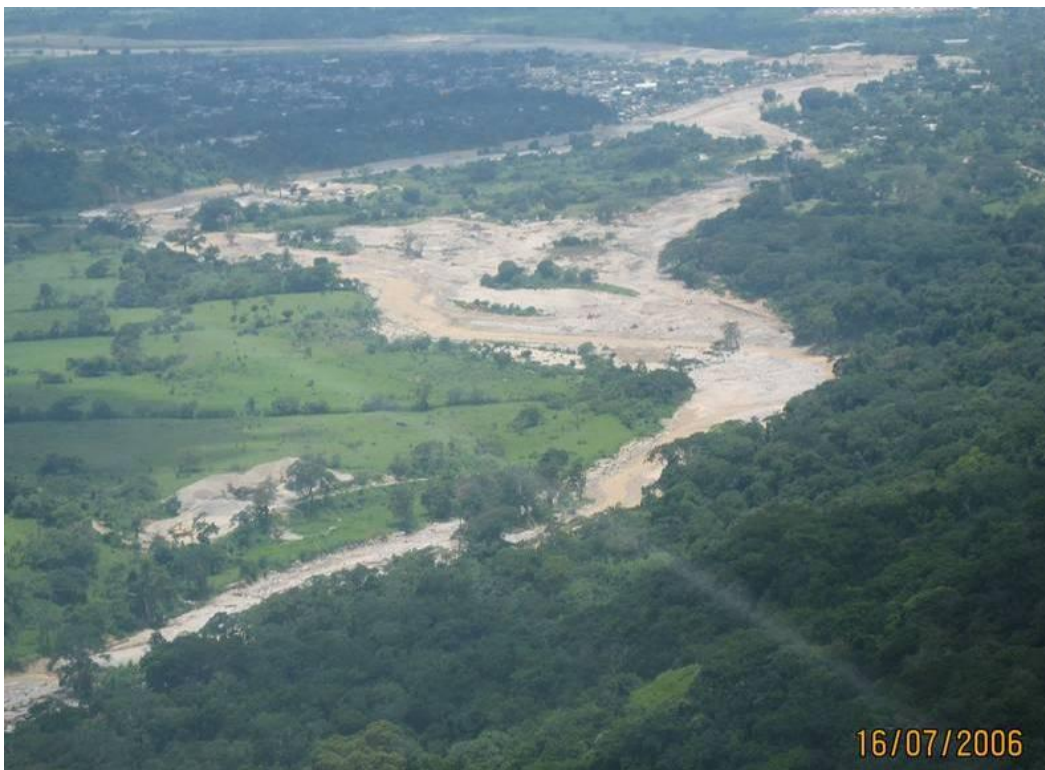
Fotografía 2.31.- Cauce del río Huixtla visto de norte a sur, hacia la margen derecha se aprecia la zona de rompimiento del nuevo brazo.
