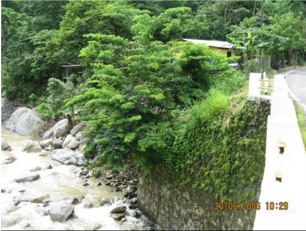
Fotografía 2.27.- Puente Río Negro sobre el cauce del Río Huixtla. Nótese las viviendas que están muy cerca del cauce.
