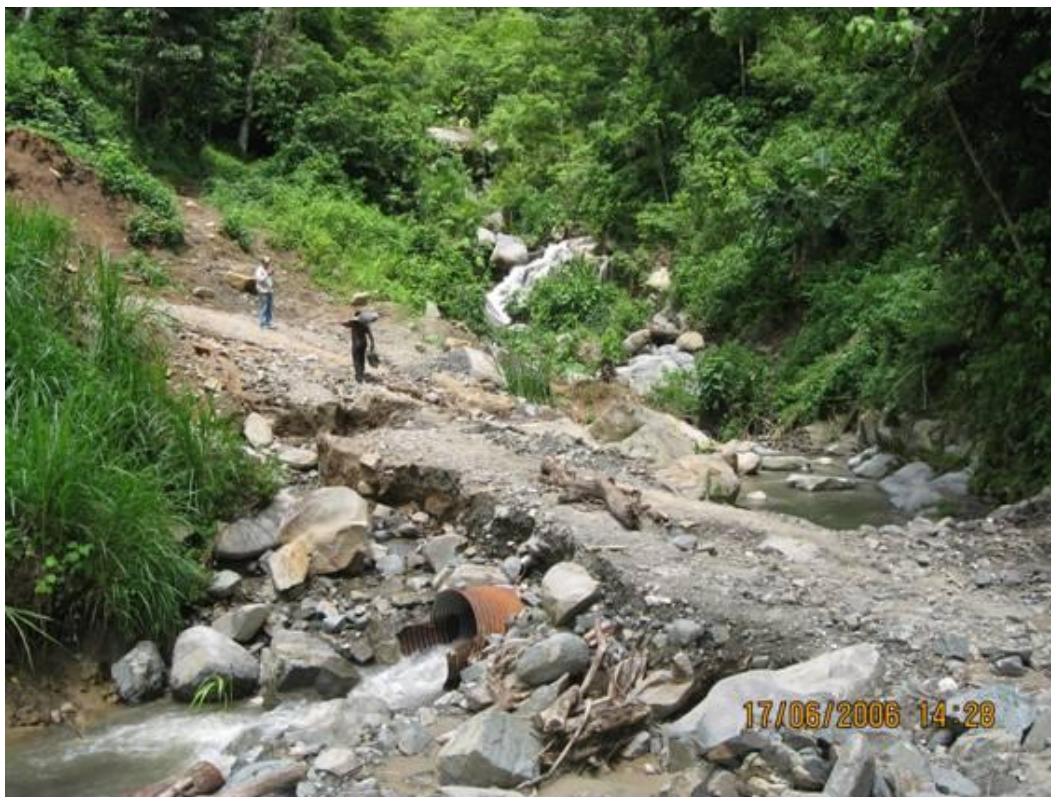
Fotografía 2.26.- Puente destruido por el paso de la corriente. Obsérvese la dimensión de los bloques arrastrados.
