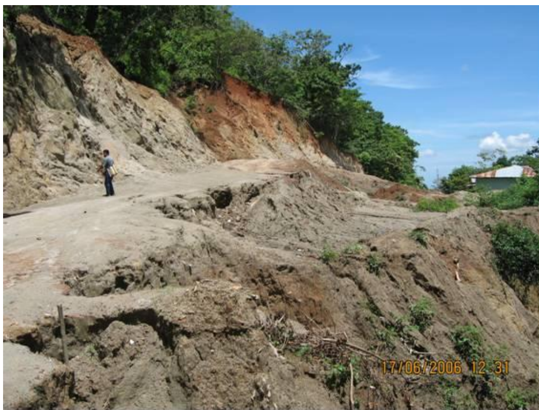
Fotografía 2.11.- Flujo de material no consolidado sobre vías de comunicación. Observe la ubicación de las viviendas.
