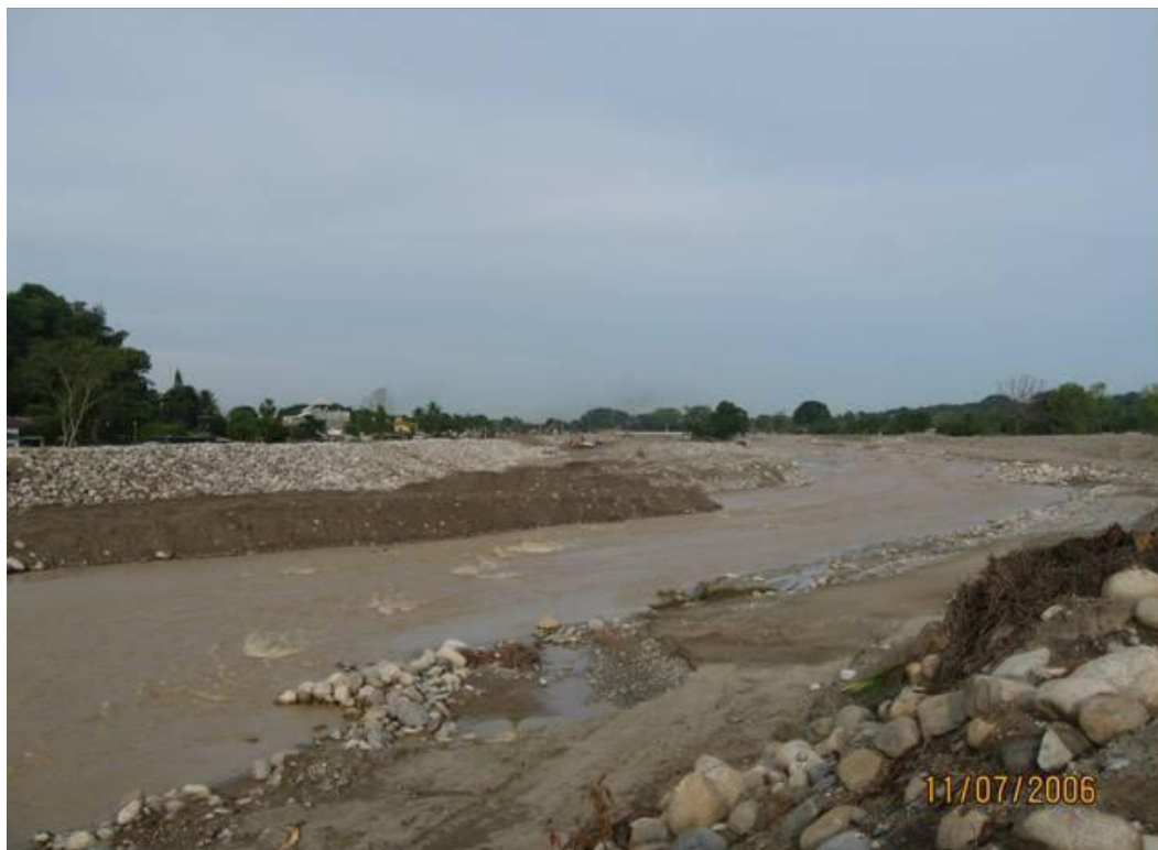
Fotografía 2.49.- Construcción de bordo de contención como obra de mitigación contra inundaciones.
