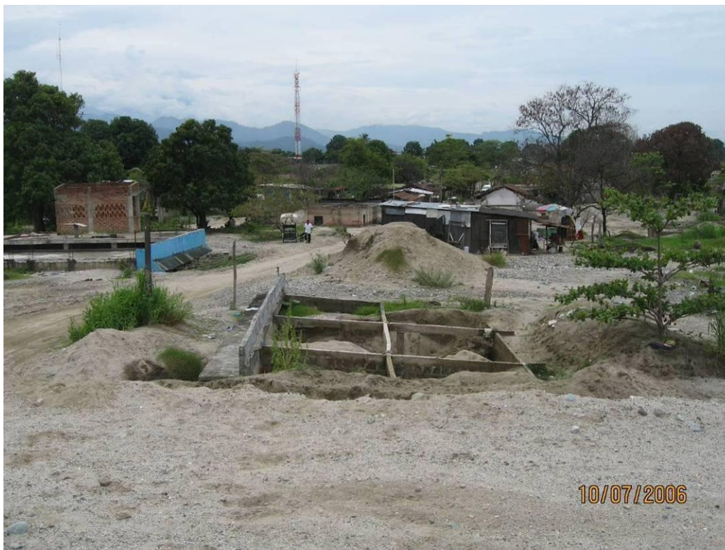
Fotografía 2.45.- Viviendas sepultadas en la colonia FONAPO, se aprecia la construcción de viviendas de lámina en zona de desastre.
