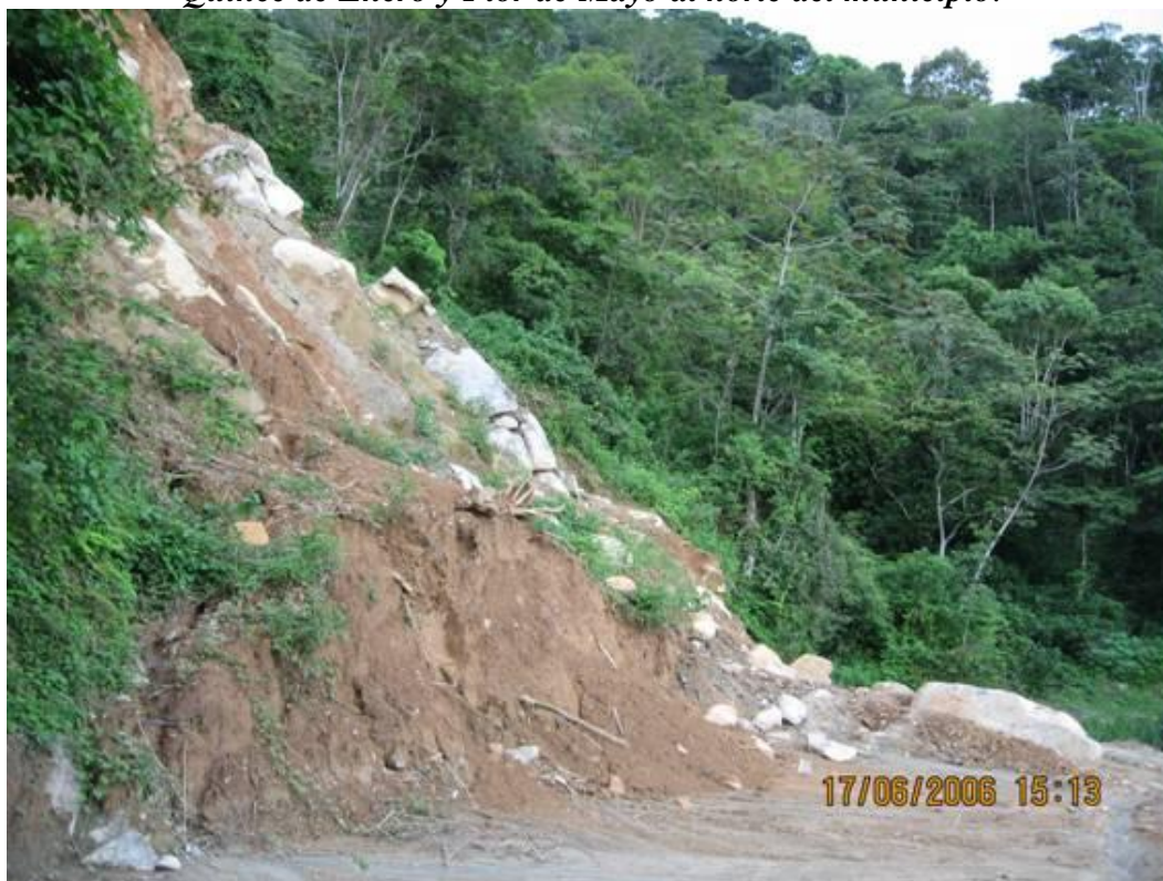
Fotografía 2.10.-Caída de bloques y roca a 300 m al SE del poblado Flor de Mayo.
