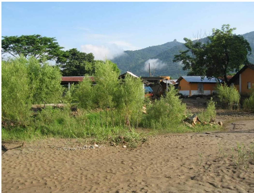
Fotografía 2.35.- Afectación a viviendas durante el Huracán Stan y en la presente época de lluvias. Se aprecian depósitos recientes de arena.
