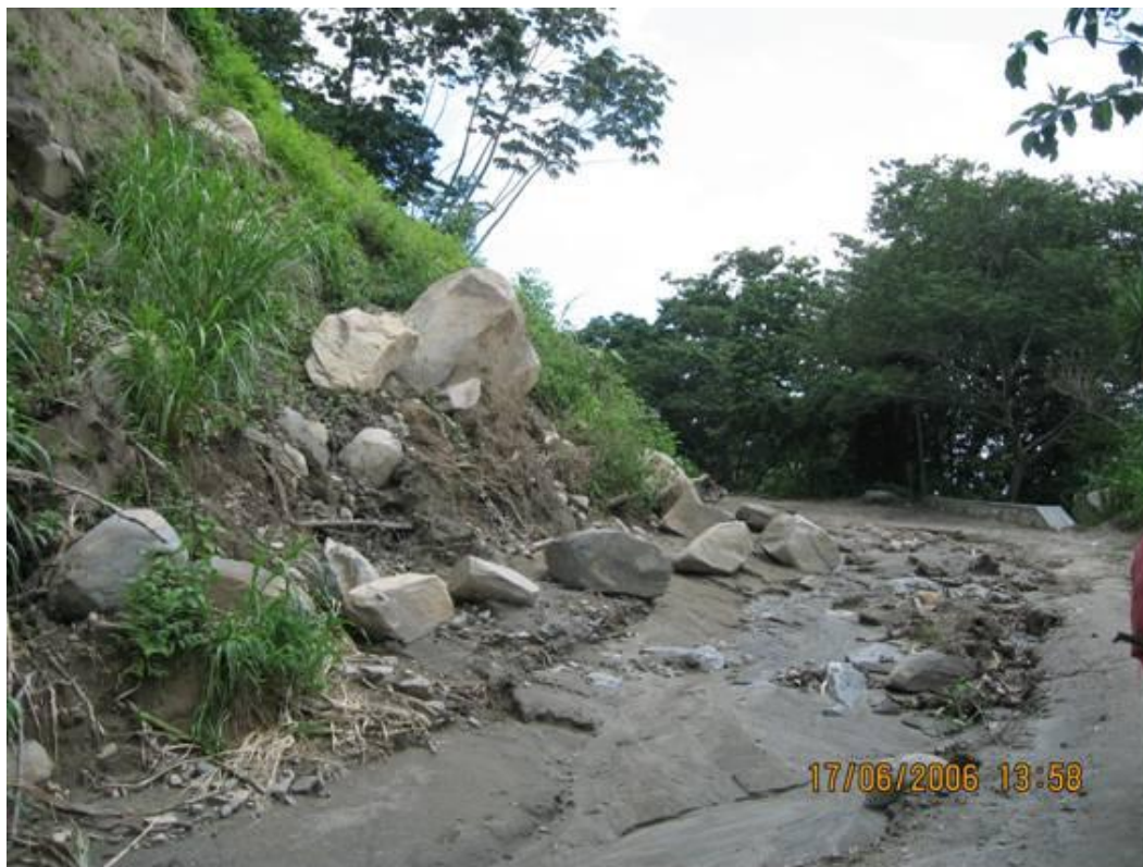
Fotografía 2.9.- Caída de bloques y roca sobre el camino que une a las poblaciones Quince de Enero y Flor de Mayo al norte del municipio.
