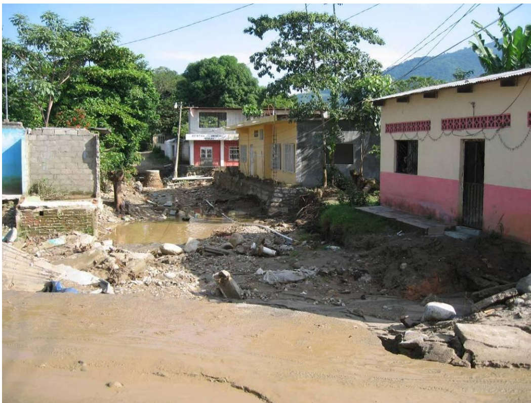
Fotografía 2.36.- Punto ubicado en calle Escorpión, se aprecian viviendas afectadas por inundaciones de tipo fluvial.
