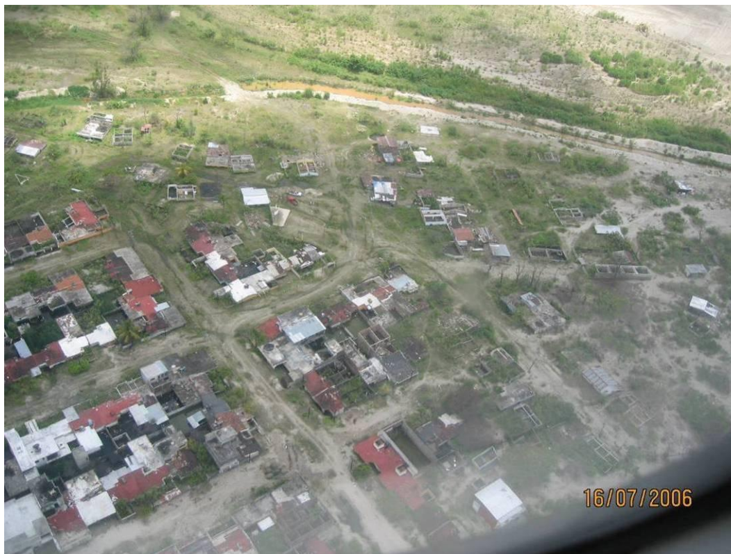
Fotografía 2.43.- Zona de desastre al sur de la ciudad de Huixtla, manzanas devastadas.
