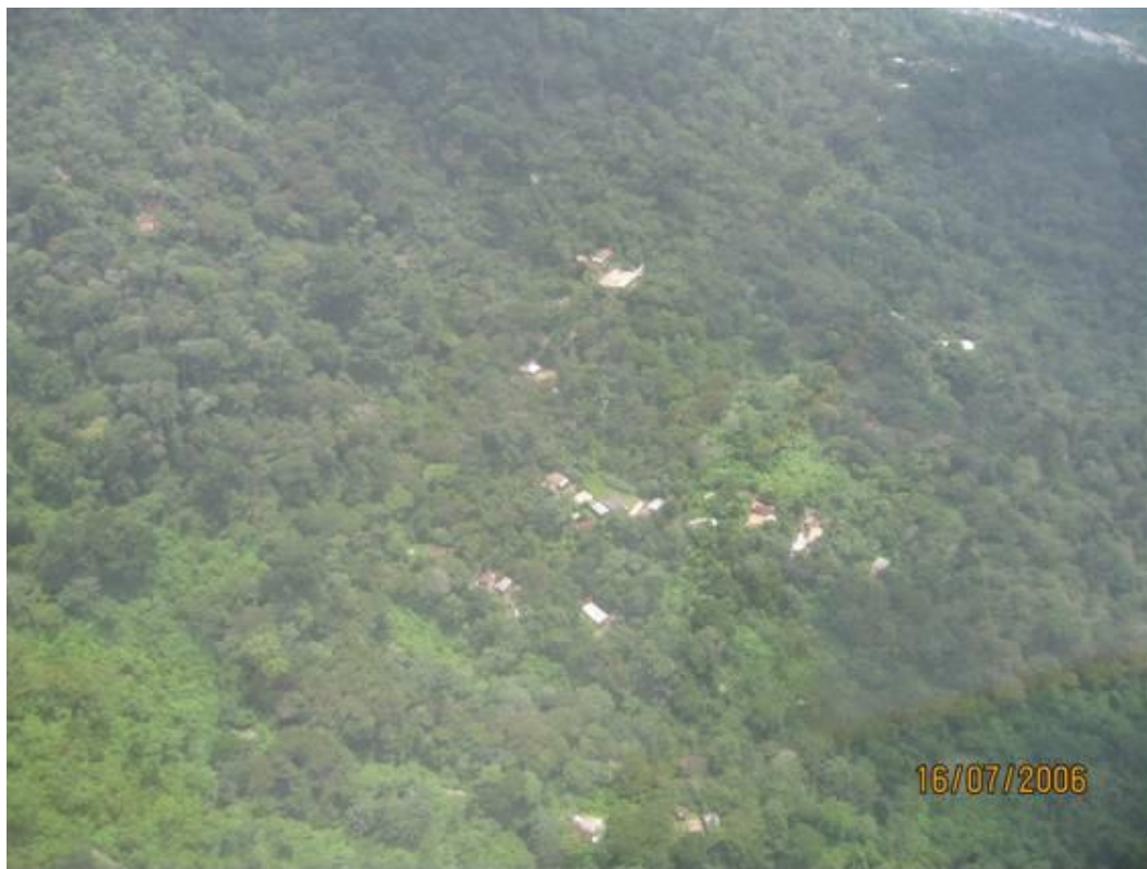
Fotografía 2.12.- Vista aérea del poblado La Esperancita. Observe que las viviendas están asentadas sobre las laderas de una montaña de pendiente fuerte.
