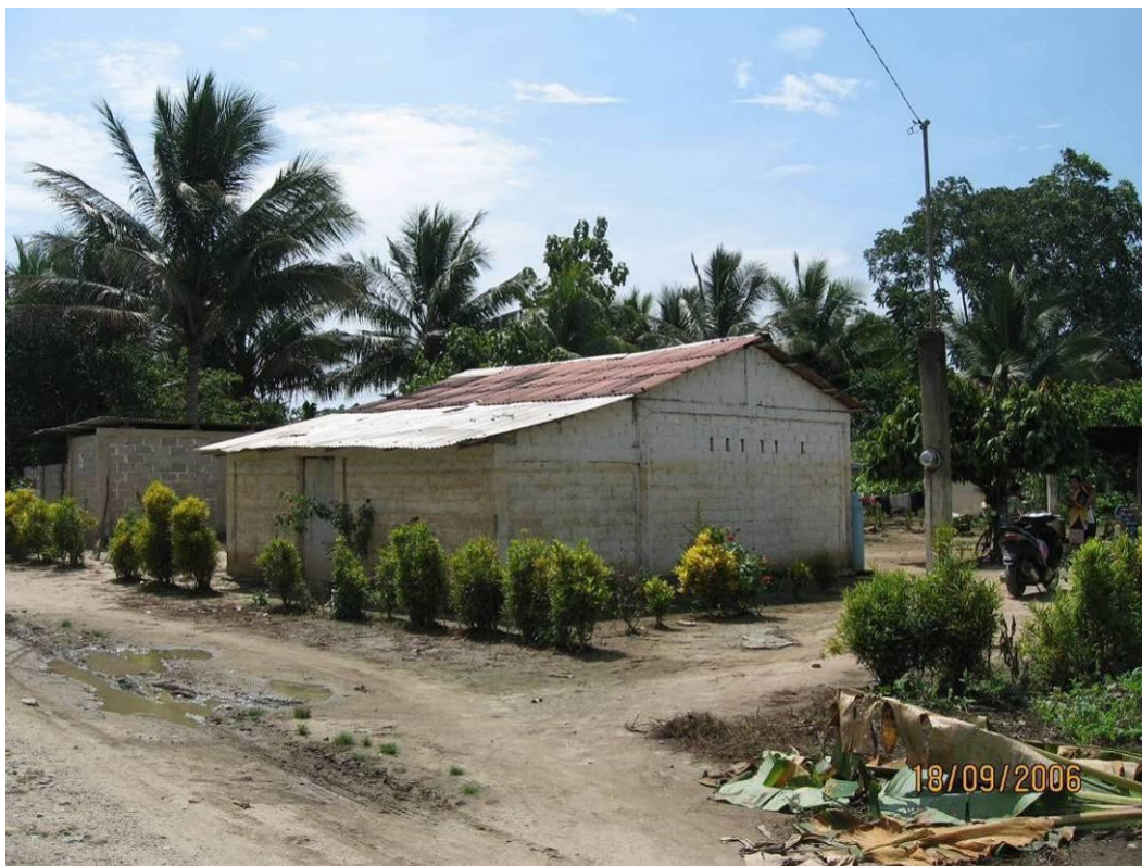
Fotografía 2.53.- Cantón San Fernando, en las viviendas aún se aprecia el nivel de agua alcanzado en esta zona.
