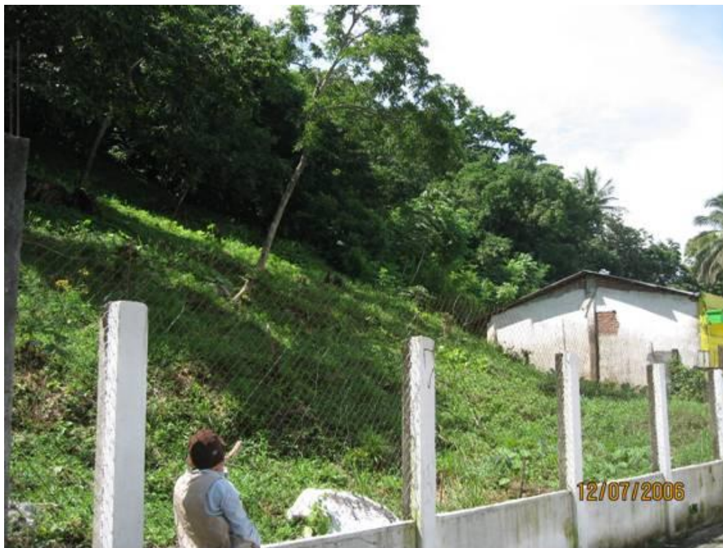
Fotografía 2.19.-Ladera con peligro de deslizamiento. Obsérvese la inclinación de los árboles.
