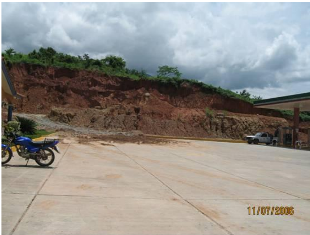
Fotografía 2.18.-Deslizamiento de material no consolidado. Obsérvese la cercanía con la gasolinera.
