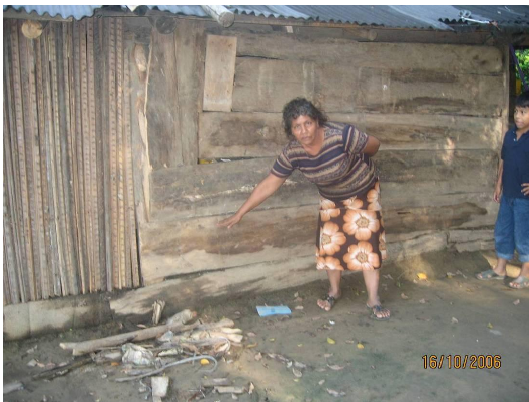
Fotografía 2.56.- Viviendas de la calle Xochimilco afectados por el desbordamiento del río Huixtla, tirante de agua de 55 cm.
