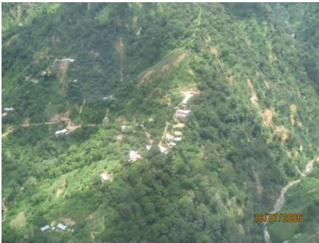
Fotografía 2.23.- Aporte de sedimentos hacia el río Etzumú, además se observan viviendas de la localidad Maíz Blanco en peligro de deslizamiento.
