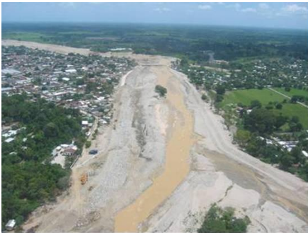
Fotografía 2.34.- Tramo comprendido entre el libramiento y el puente de la carretera federal No. 200 (vista NE-SW). Observe la amplitud del cauce después del Huracán Stan.
