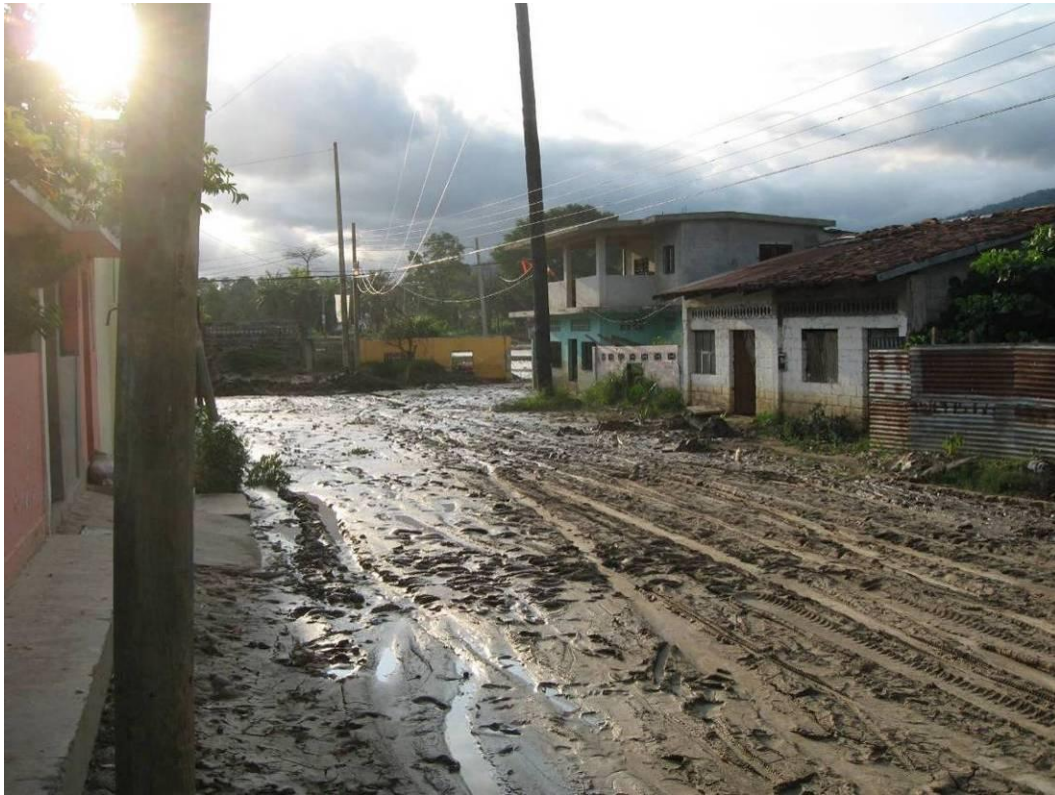
Fotografía 2.41.- Viviendas en peligro alto por inundación localizadas en la calle Francisco Zarco, entre Av. Aldama y Av. Matamoros, afectadas por recientes desbordamientos del río.
