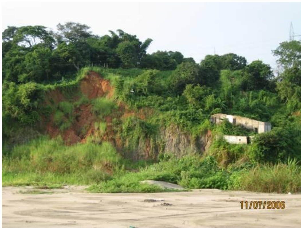
Fotografía 2.15.-Evidencias de deslizamiento en la margen izquierda del Río Huixtla.
