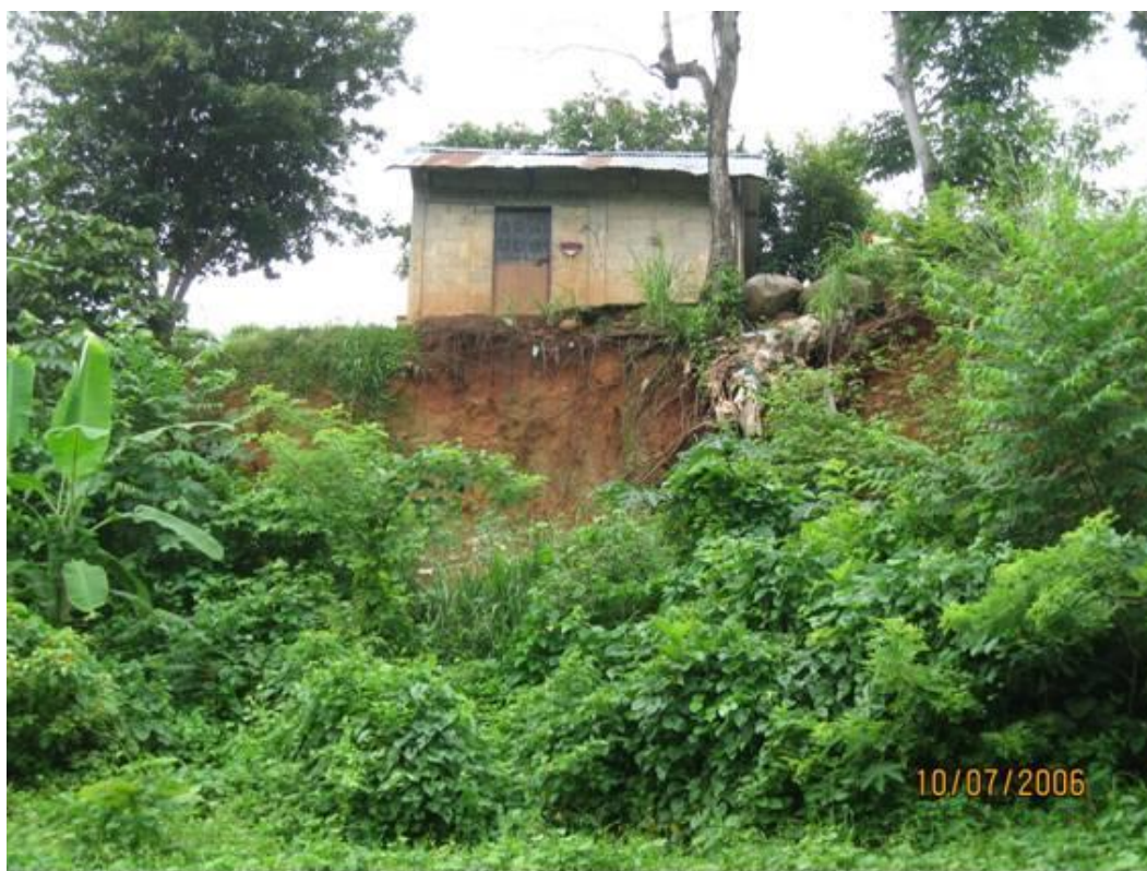
Fotografía 2.16.-. Escarpe de deslizamiento, observe la vivienda ubicada sobre la corona en peligro por desplome.
