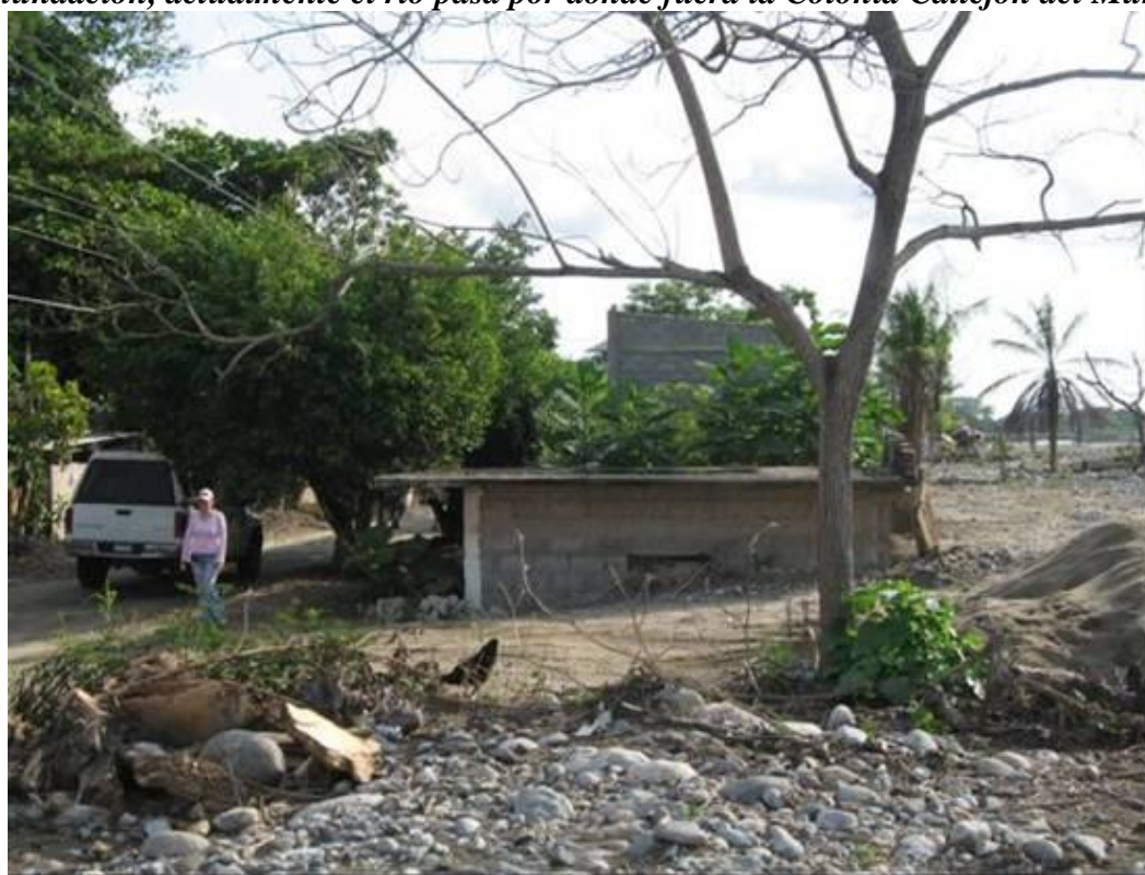
Fotografía 2.38.- Aún se logran apreciar viviendas sepultadas por el flujo de escombros en la colonia Callejón del Muro.
