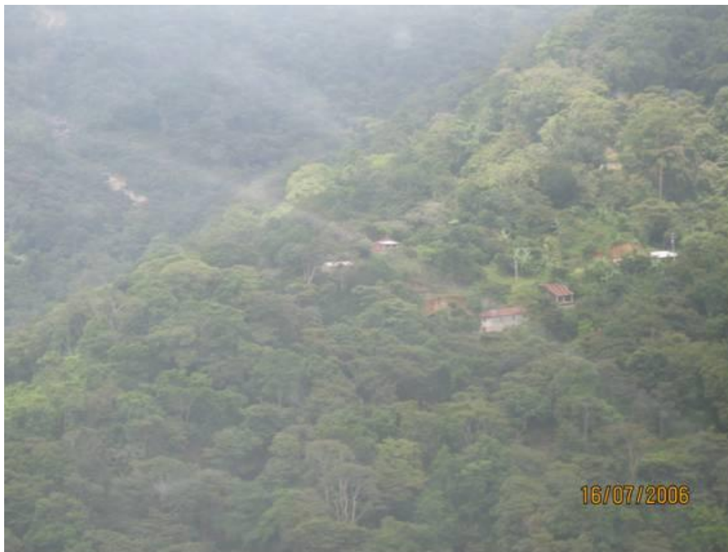
Fotografía 2.13.-Poblado El Zapote. Observe las viviendas que están sobre una ladera de pendiente fuerte.
