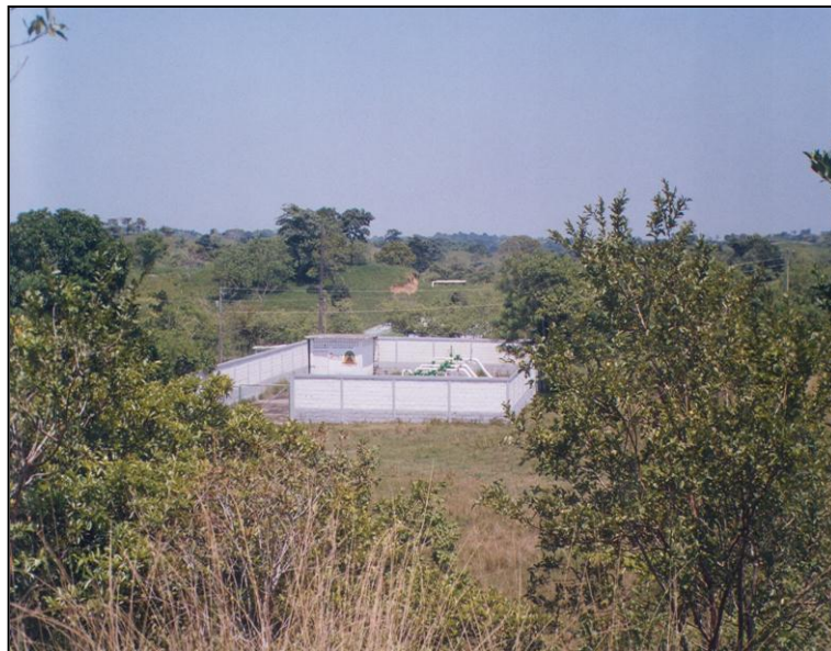
Fotografía 6.- Cabezal Chirimoyo, que se localiza en el crucero a Linda Vista.
