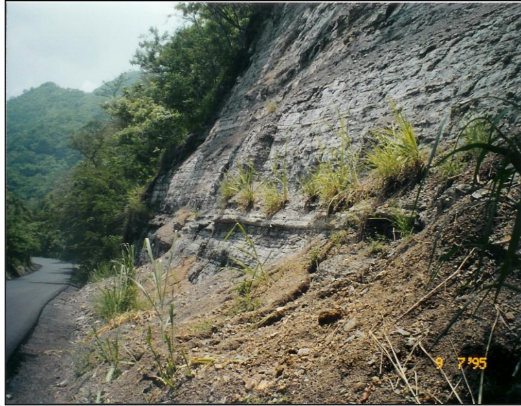
Fotografía 3.- Deslizamientos de roca, en el trayecto de Grano de Oro a Las Flores, afectando las vías de comunicación.
