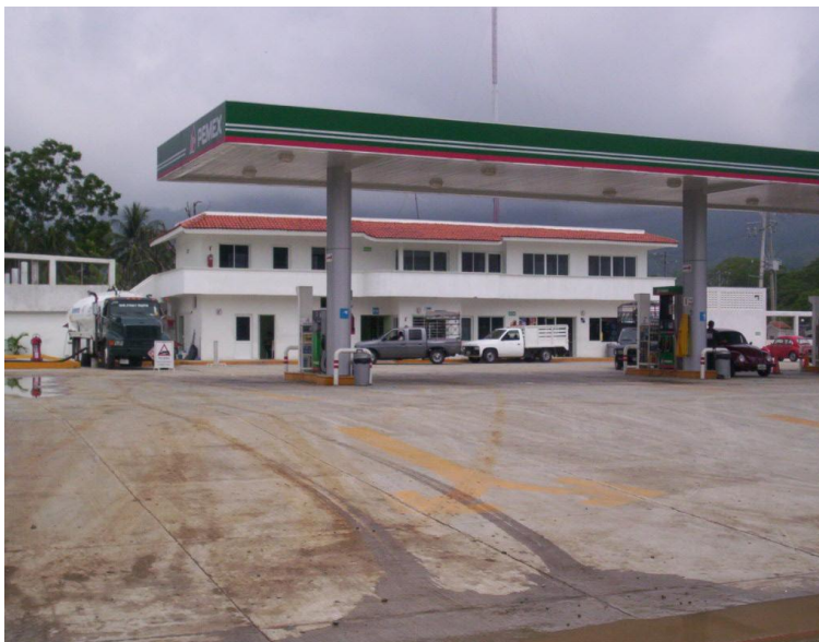
Foto No. 28.- Gasolinera Autol, con capacidad de almacenamiento de 2 de 50,000 l, se ubica la carretera Pichucalco-Teapa km 1, esquina Libramiento-Tuxtla.
