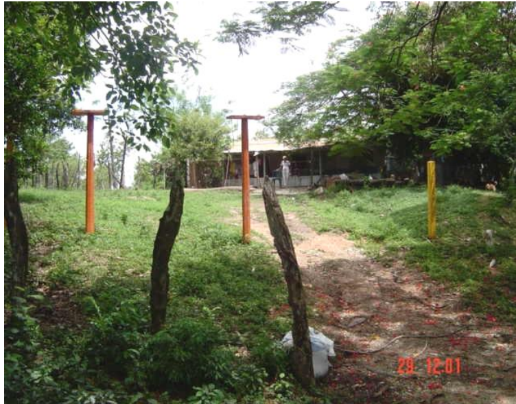
Foto No. 26.- Oleoducto que pasan a 25 m de una casa, en el Campo Chiapas, 2da. Sección.
