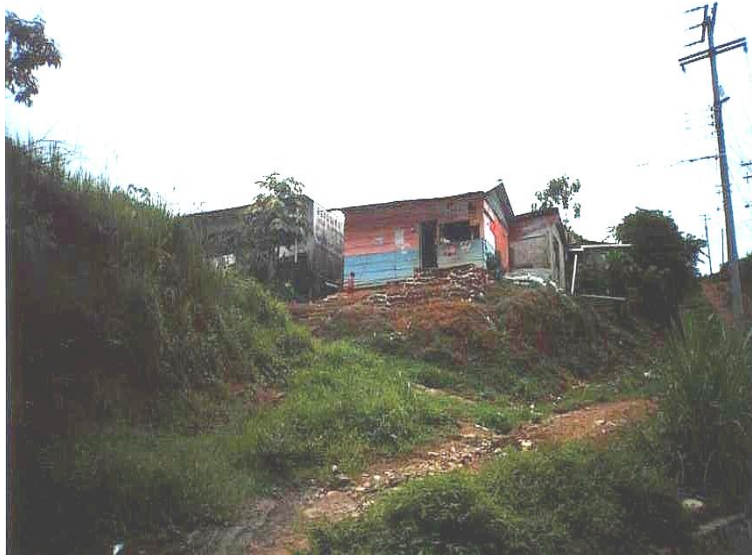
Foto No. 11.- Casas al punto de caerse provocado por deslizamientos a un lado del centro social "El Mirador". Presenta en su base costales para evitar que se derrumbada. Colonia el Mirador.
