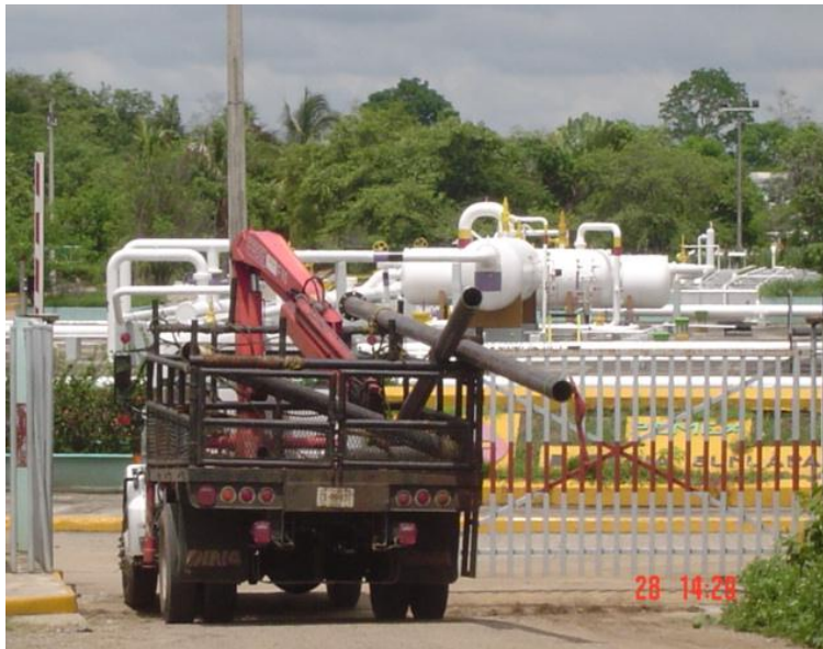
Foto No. 22.- Vista de la entrada de la Batería Compresora Sunuapa, se observan algunos tanques de almacenamiento en buen estado.
