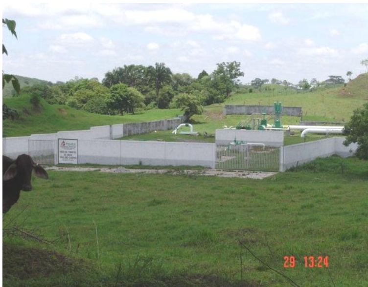
Foto No. 25 Área de trampas de ductos Giraldas-Chiapas, aquí se produjo un conato de explosión hace aproximadamente 5 años.
