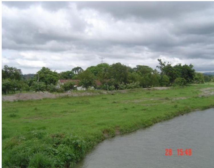
Foto No. 15.- se observa una casa, que cuenta con un borde de protección hecho de arena de aproximadamente 2 m de altura, el río Platanar tiene un ancho de 120 m y un borde natural de 40 cm.
