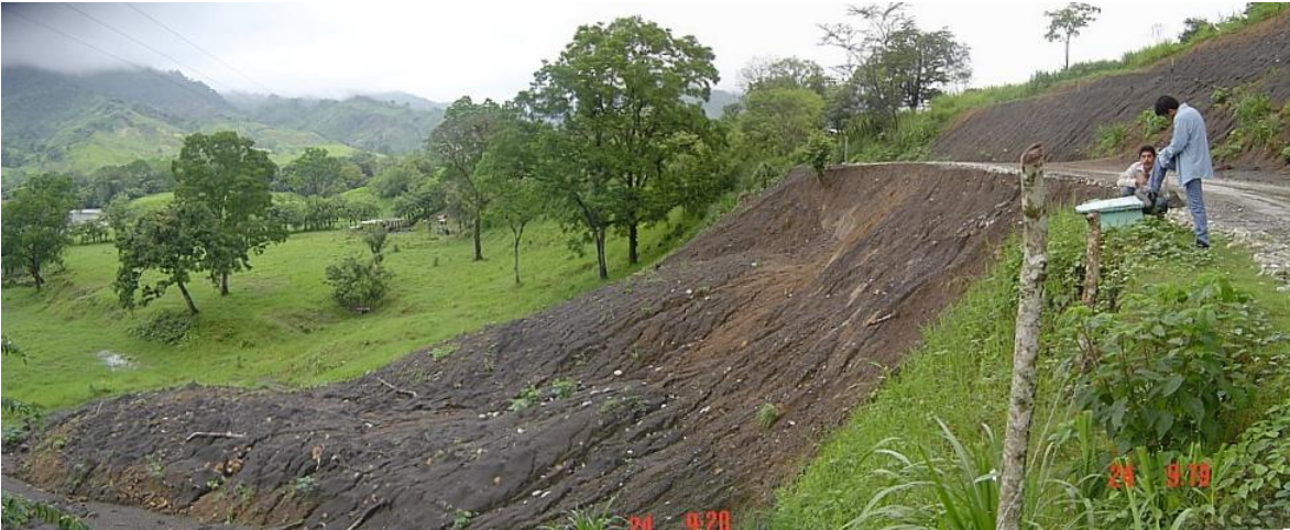
Foto No. 14.- Se observa escombros provocados por un deslizamiento debido a la intensa lluvia. A 700 m al Este del poblado de Tectuapan.
