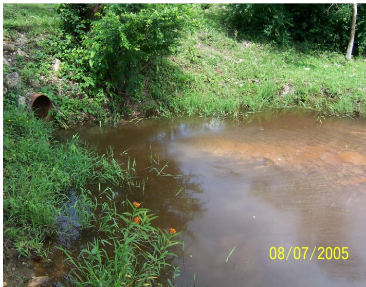
Fotografía 27.- Descarga de aguas residuales hacia cuerpos de agua (REF06 fichas sanitarias), probablemente proviene de las instalaciones de Nuevo PEMEX, se aprecia una capa de aceite.
