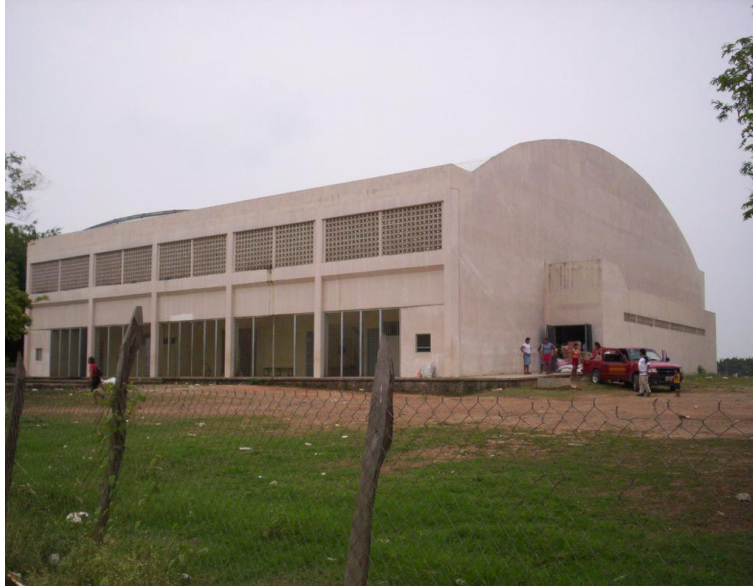
Fotografía 30.-Auditorio Municipal Reforma. Centro de refugio temporal.
