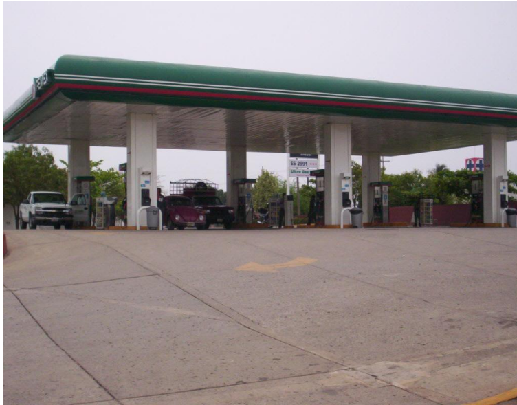
Fotografía 13.- Estación de servicio Nueva Reforma
