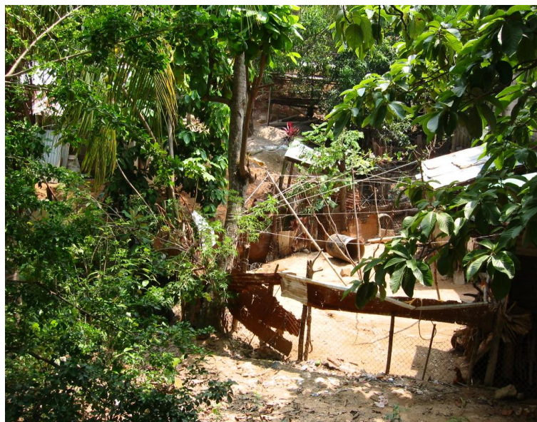
Fotografía 12. Calla Río Grijalva. En este punto se encuentran viviendas construidas sobre el cauce de un arroyo, colocándolas en riesgo alto ya que es una zona con altas posibilidades a inundarse.
