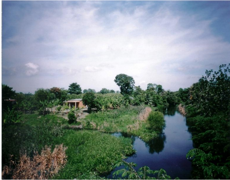
Fotografía 10.- Estancia Vieja. Viviendas en peligro por inundación a orillas del río Mezcalapa.
