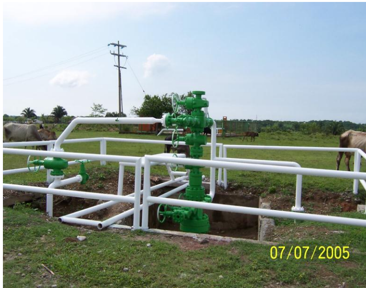
Fotografía 18.- Pozo Cactus 61. Ubicado en terrenos de pastoreo.
