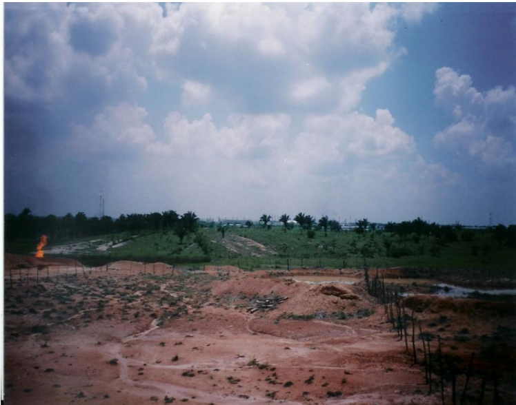
Fotografía 17.- Mechones de compresión en el Ejido El Carmen, los cuales han causado problemas a la población debido a su escasa seguridad.
