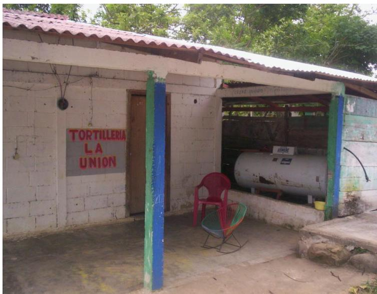
*Fotografía 5. Se observa tanque de almacenamiento de gas LP, en buenas condiciones.*
