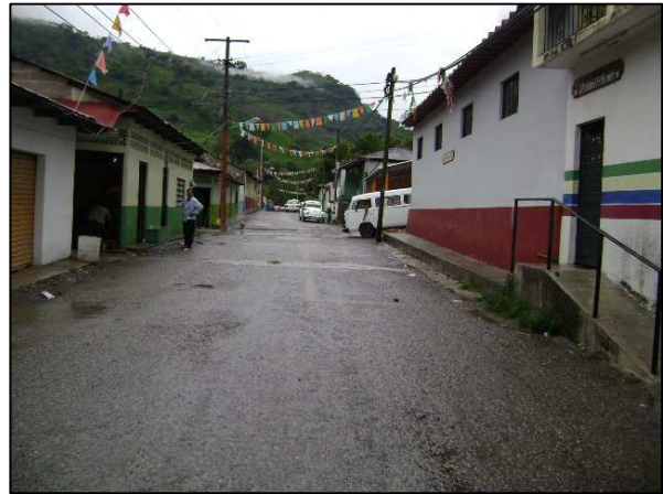
Vialidad de pavimento de concreto hidráulico
