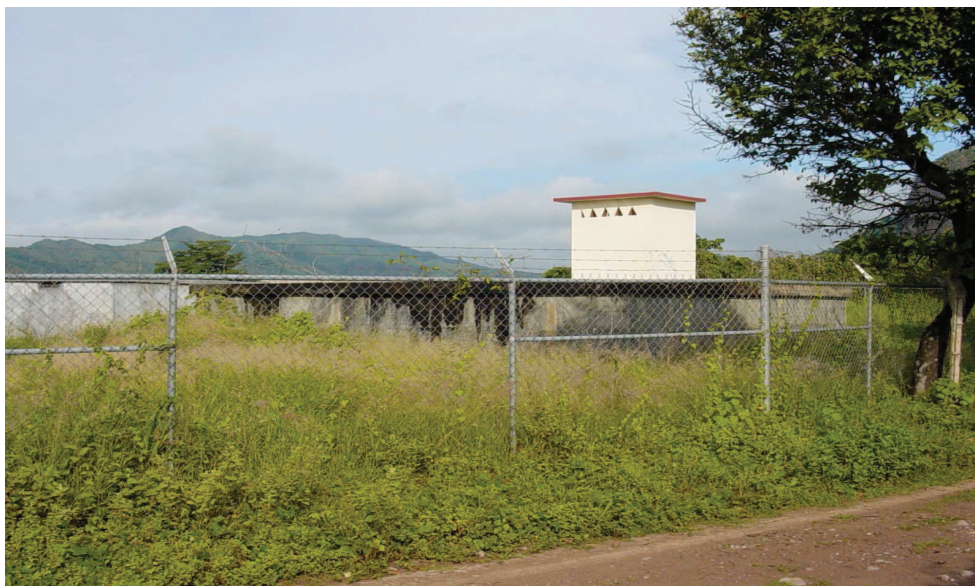
Tanque de almacenamiento de agua Juquila
