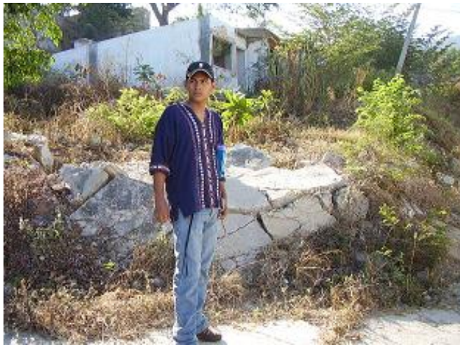
Foto 14. Deslizamiento en el fraccionamiento Cueva del Jaguar.
