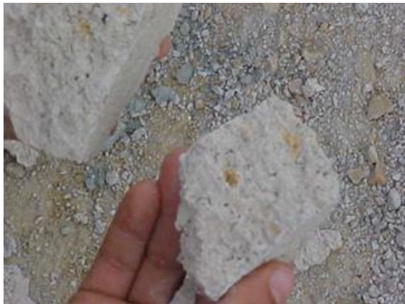
Foto 34. Fragmento de bloque de concreto contaminado con materia orgánica.
