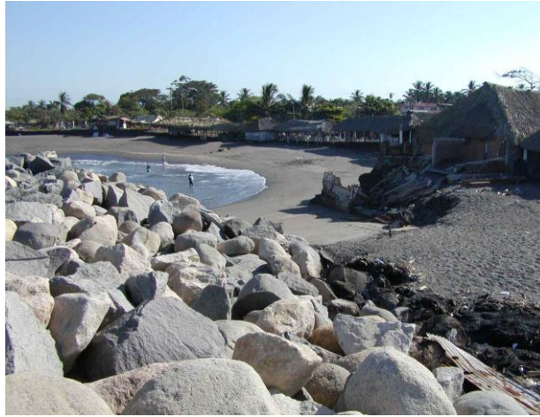
Fotografía 14.- Bahía al norte y atrás de la serie de rompeolas en Puerto Madero. Esta bahía se formó por efecto de turbulencia generada por el rompeolas. Aquí la profundidad que se incrementa rápidamente y la turbulencia son un factor de riesgo para los bañistas
