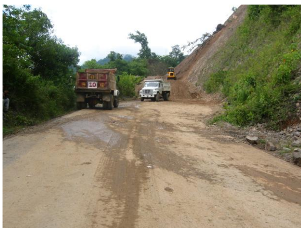
Fotografía 51. Carretera de Ángel Albino Corzo a Siltepec, en donde en el mes de septiembre se produjo el deslizamiento que obstaculizó el tránsito a las poblaciones de Capitán A. Luís Vidal, Monte Cristo de Guerrero y Nueva Independencia, y a otras localidades de menor tamaño.
