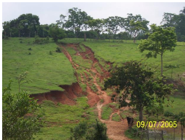
Fotografía 46. Etapa erosiva del terreno muy avanzado debido a la acción hídrica concentrada, condiciones que se presentan en la terracería que conduce de Reforma a la localidad de Paraíso.
