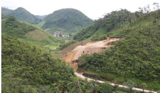
Fotografía 59.- Construcción de camino que comunica a los Ejidos Rosario-Tierra Blanca, obsérvese la deforestación del área, así como la zona afectada con deslizamientos sobre el camino.
