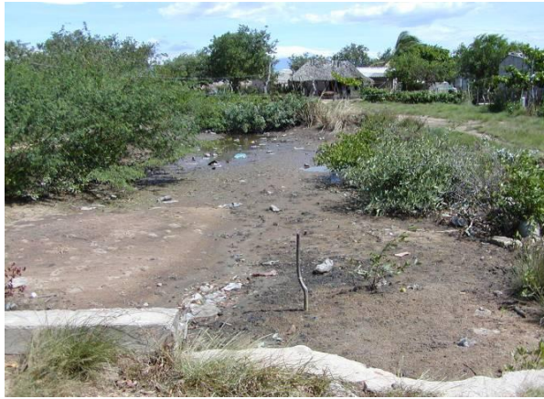
Fotografía 100.- Casas al lado de canales de inundación, construidas a menos de 1 msnm en la comunidad pesquera y turística de Punta Flor
