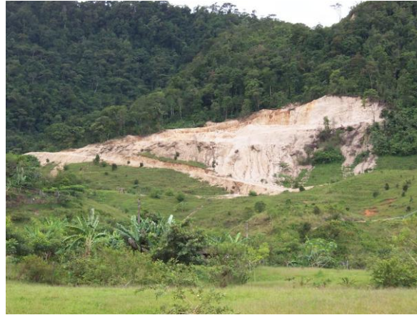
Fotografía 76.- Banco de extracción de material en el Ejido Rivera de la Selva (CH 14), se puede observar el área de deslizamiento sobre terrenos deforestados.
