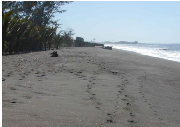
Fotografía 15.- Playa Linda, a aproximadamente 400 m al norte del extremo norte de los rompeolas (sitio de la foto izquierda). La erosión continúa siendo severa y ha derribado algunas construcciones. La línea de costa ha retrocedido más de 150 m.
