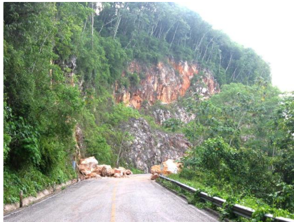
Fotografía 37. Caída de roca sobre la carretera relativamente nueva número 307 a la altura del poblado Flor de Café, lo cual es una consecuencia de la erosión que persiste en la zona, ya sea por obras civiles o por la ausencia de vegetación que sostenga la roca altamente fracturada.
