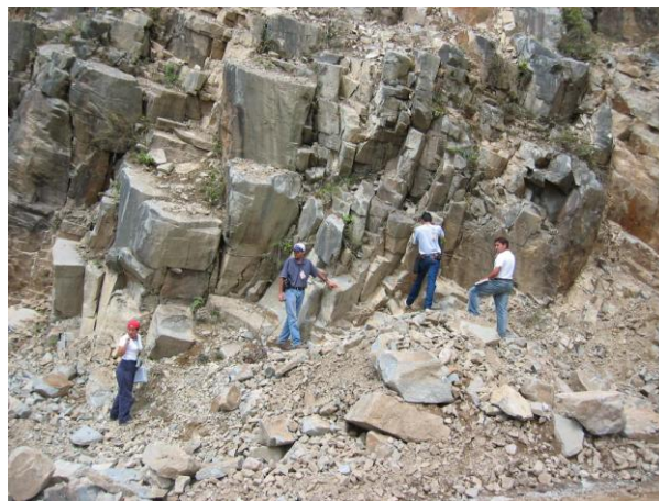
Fotografía 64.- Obsérvese el estado de la roca con intenso fracturamiento sobre la carretera en construcción de Tapalapa a Ocoatepec.
