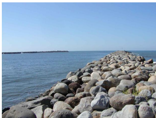
Fotografía 12.- Espigones de protección a la entrada al Puerto Madero, los cuales tienen una longitud de más de 300 m
