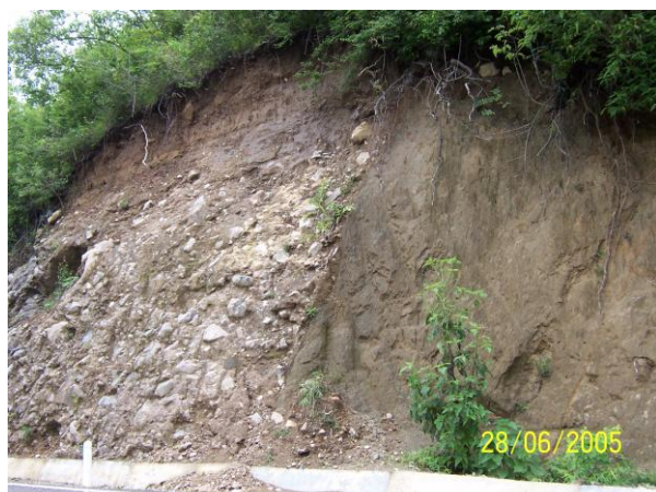
Fotografía 87.- Contacto entre brecha volcánica y granito alterado, en temporada de lluvia se presentan algunos deslizamientos sobre la carretera.
