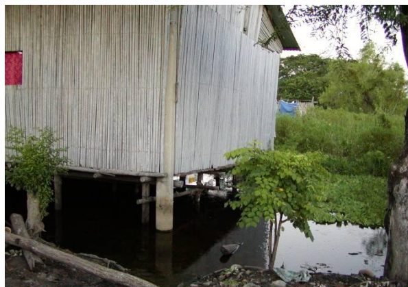
Fotografía 101.- Casa construida en terreno sujeto a inundación. Nótese la marca en el poste, correspondiente al nivel que comúnmente alcanza el agua.
